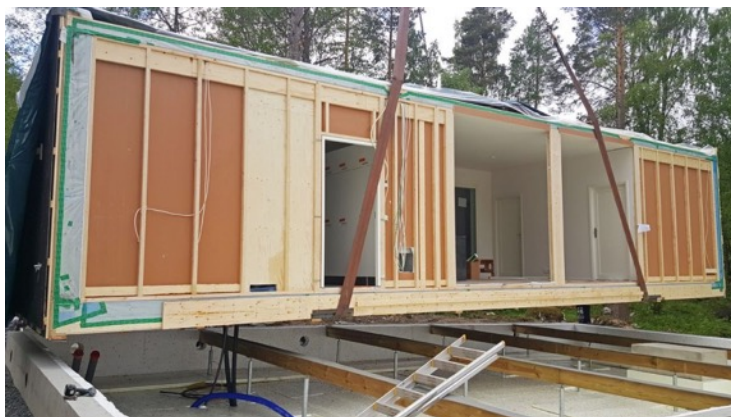
16. Tilaelementin nostoa paikoilleen. Kannustalo Oy:n verkkosivut.
