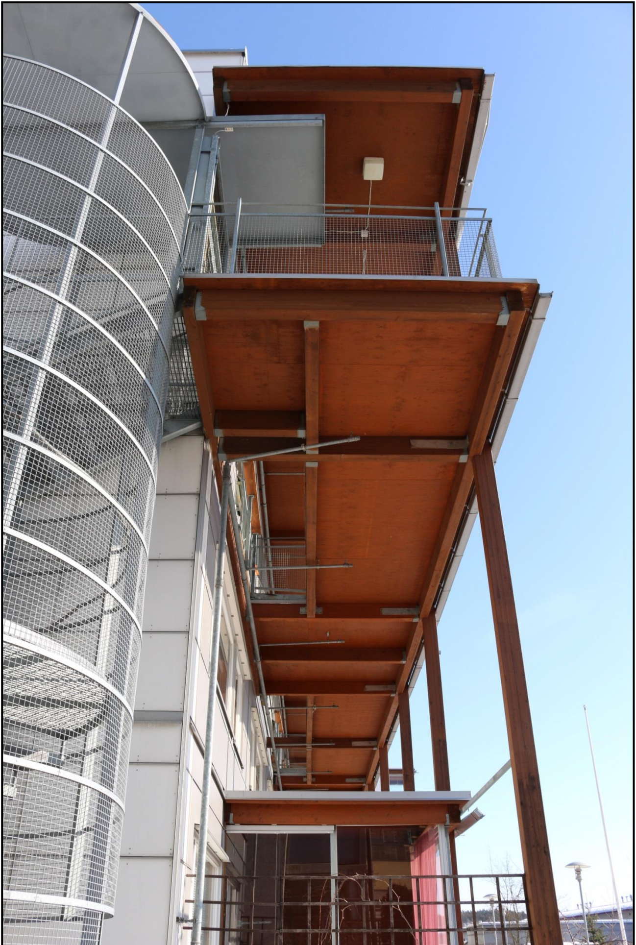
Kuva 14: Käynti asuntoihin luhtikäytävältä siltaa pitkin.
