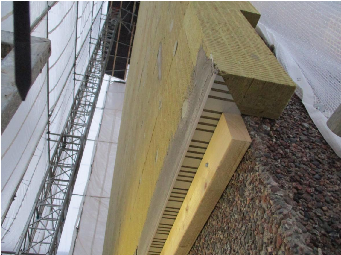
KUVA 2. Alajuoksuohjain (Kuva: Aksu Virtanen 2018)
