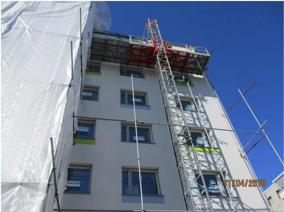
KUVA 8. Valmis julkisivu. Mastolavan purkutyöt käynnissä (Kuva: Aksu Virtanen 2018)
