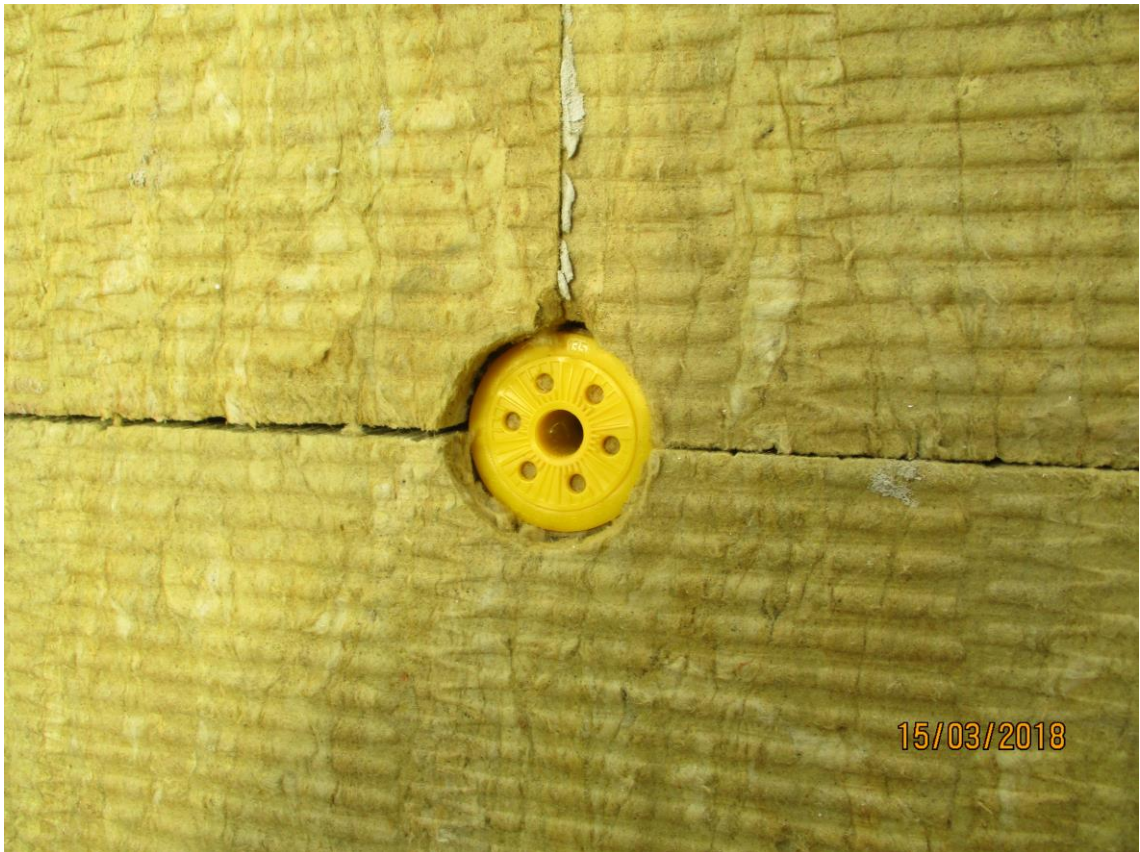
KUVA 4. Mekaaninen kiinnike (Kuva: Aksu Virtanen 2018)
