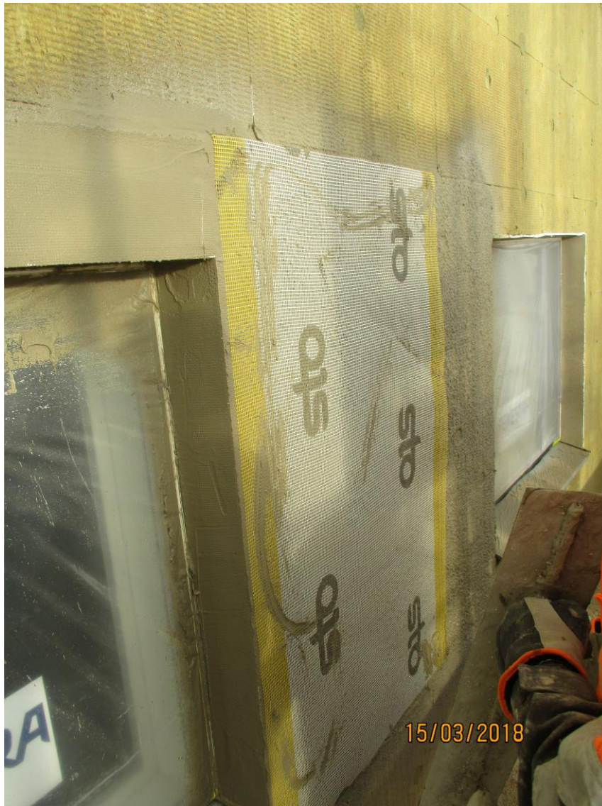
KUVA 6. Vahvikeverkon asentaminen (Kuva: Aksu Virtanen 2018)
