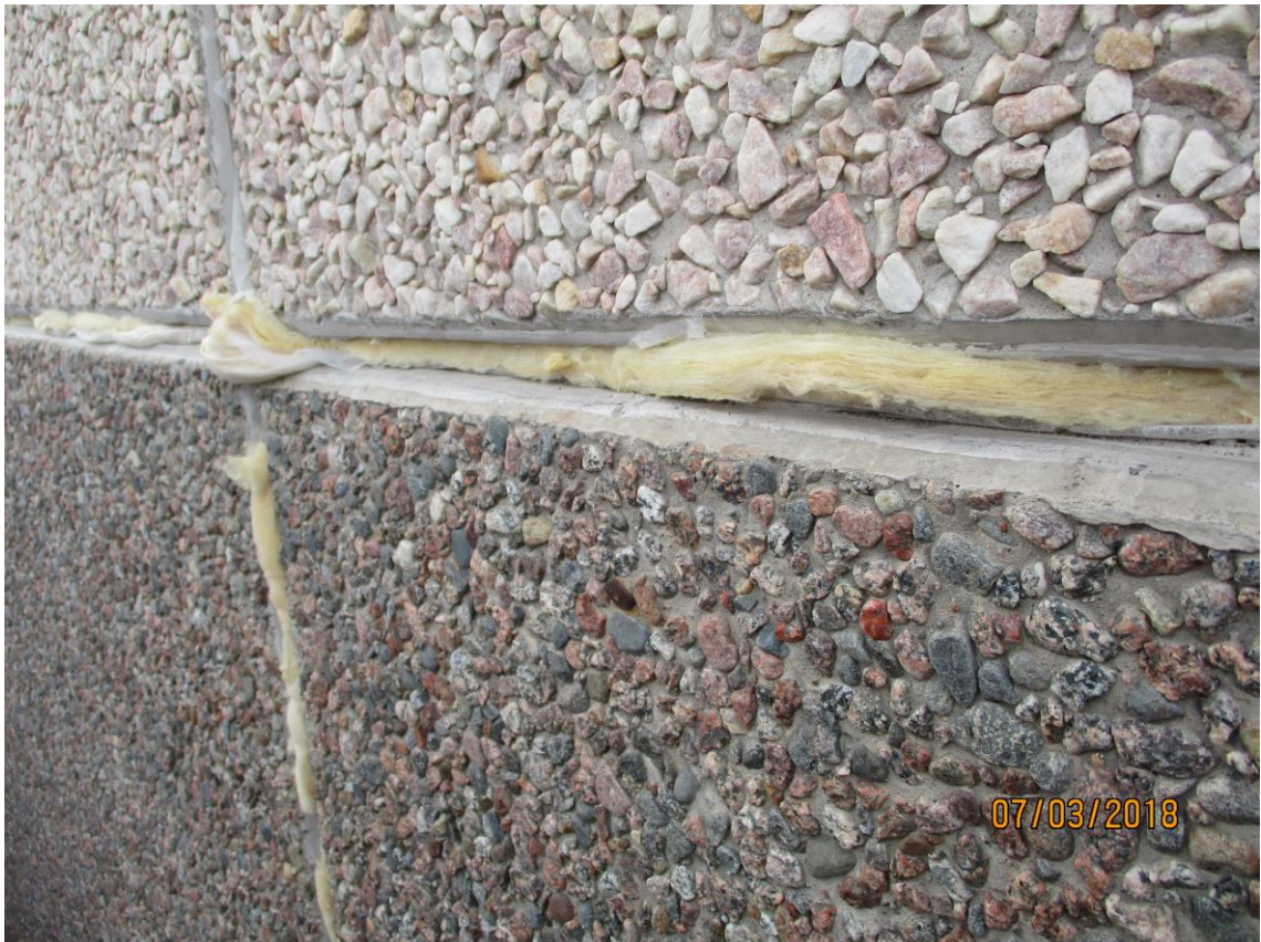
KUVA 1. Elementtien saumat avattu ja tilkitty. (Kuva: Aksu Virtanen 2018)
