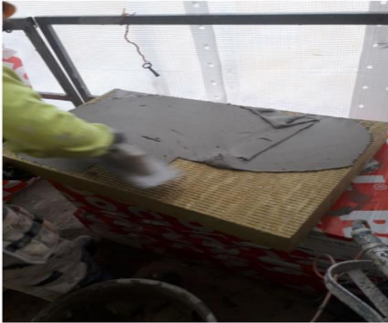
KUVA 3. Liimalaastin levitys eristeelle (Kuva: Aksu Virtanen 2018)
