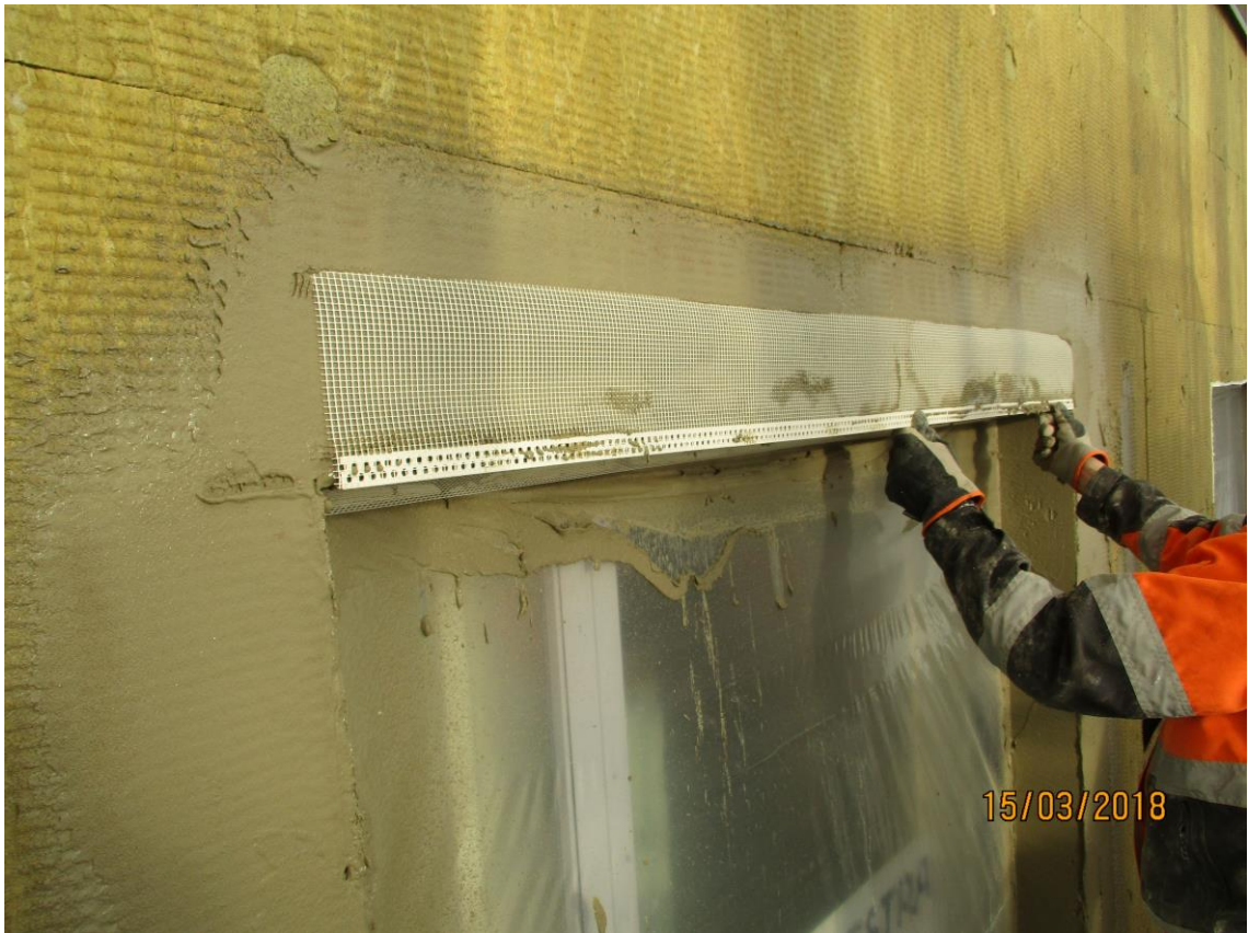
KUVA 5. Kulmavahvikeverkon asentaminen (Kuva: Aksu Virtanen 2018)
