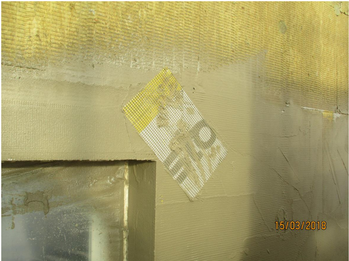
KUVA 9. Ikkunan nurkkaan asennettava diagonaaliverkotus (Kuva: Aksu Virtanen 2018)
