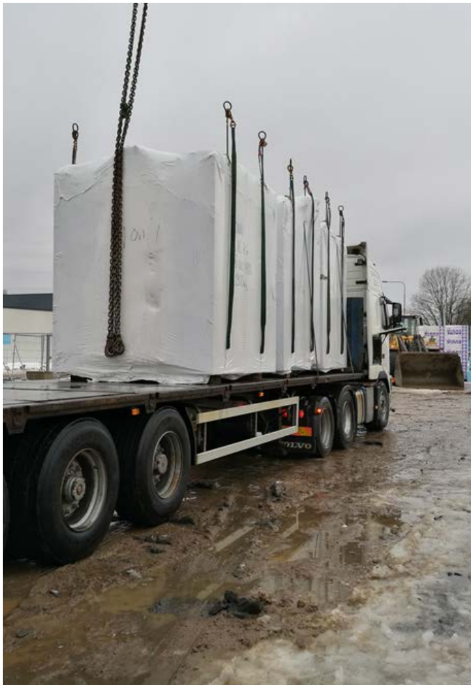
KUVA 11. Vaihtelevat työmaaolosuhteet luovat haastetta
