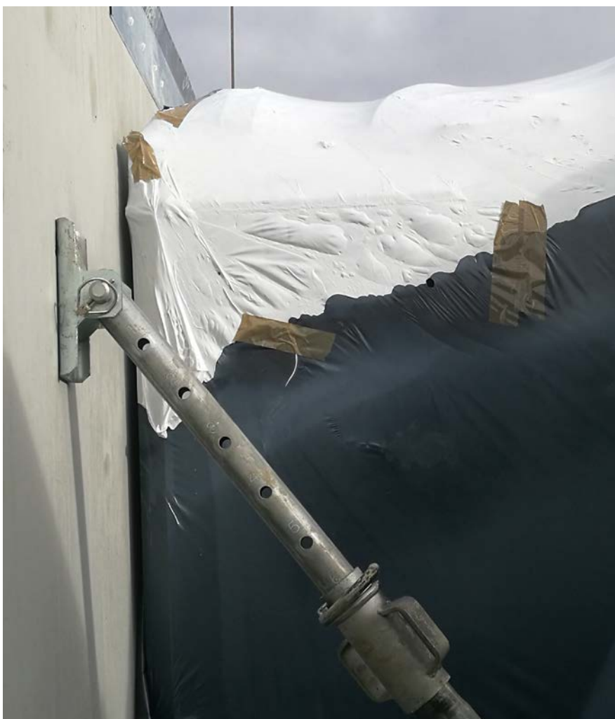
KUVA 12. Työmaalla tehtyjä suojamuovin paikkauksia
