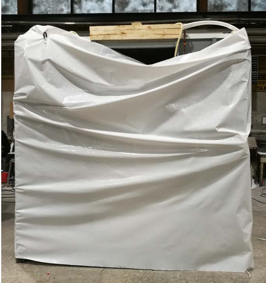
KUVA 7. Kylpyhuone-elementin kutistemuovi ennen lämmittämistä
