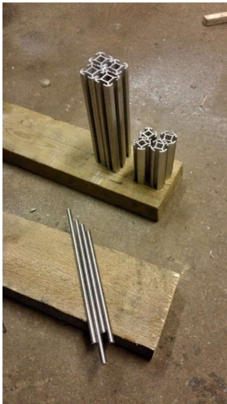
Kuva 11. Laitteen runko ja liikutangot valmistusvaiheessa.
