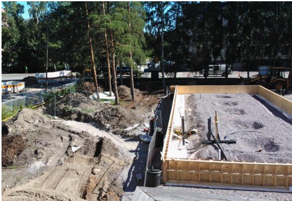
Kuva 2. Reunavahvistetun betonilaatan asennustyöt (Huitti 2014)
