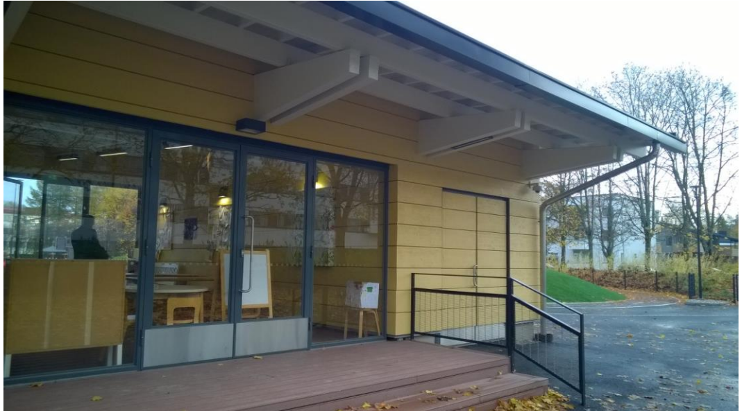
Kuva 4. Lpr Mäkitorpan kattorakenteet ja valittu julkisivuväri
