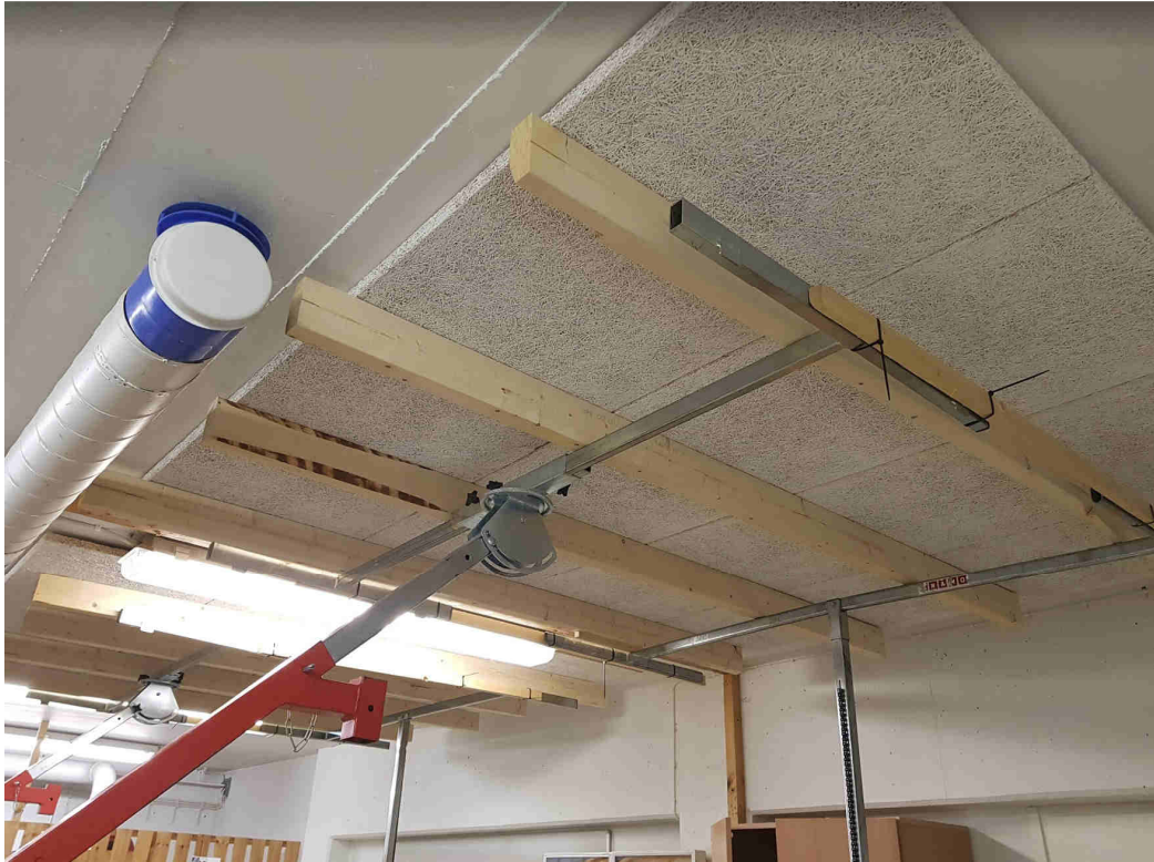
Kuva 8. Levyrakenteet asennettuna mittausta varten levyhissejä apuna käyttämällä.
