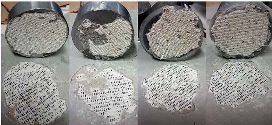
Kuva 9. Vetonapin murtopinta ja Dekofloor-pinnoitteen murtokohta betonipinnasta.
