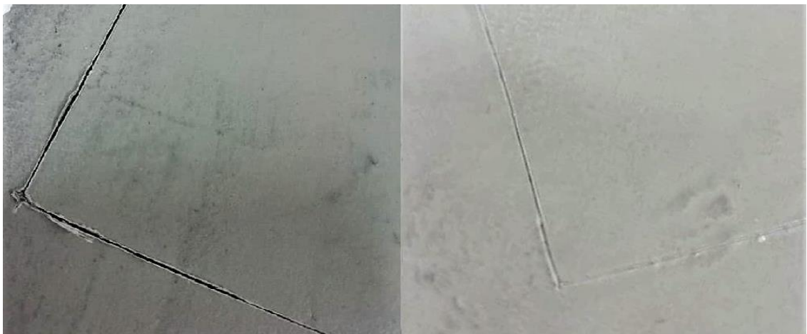
Kuva 13. Viiltojäljet Dekofloor (vasen) ja Pavicem (oikea) -pinnoitteissa.
