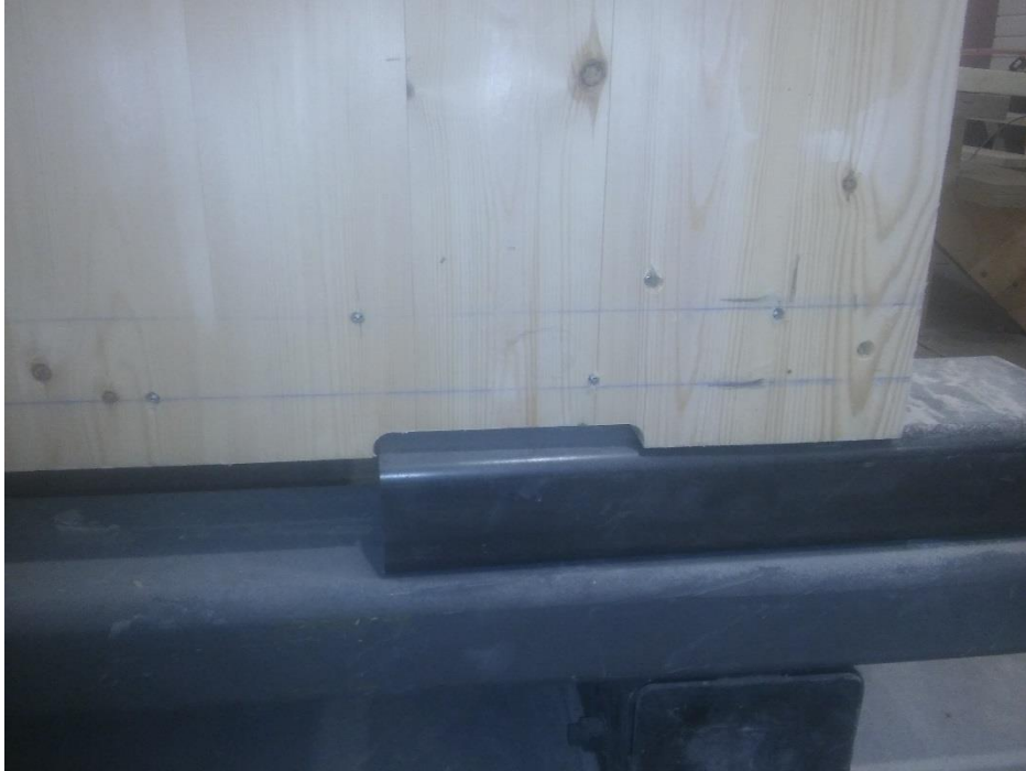
Kuva 6. Nostoliinaa varten työstetty ura levyn pohjalla.
