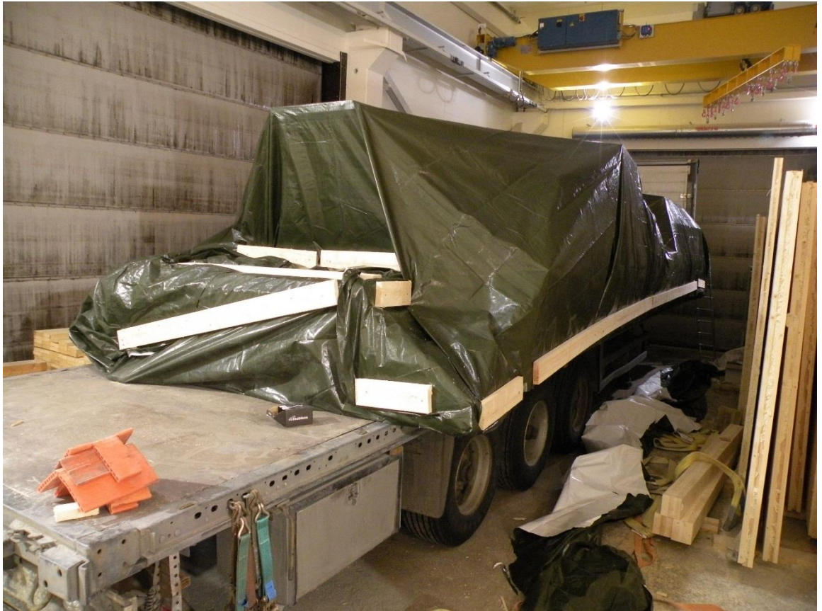
Kuva 2. Pressulla suojattu lapekuorma odottamassa sitomista.
