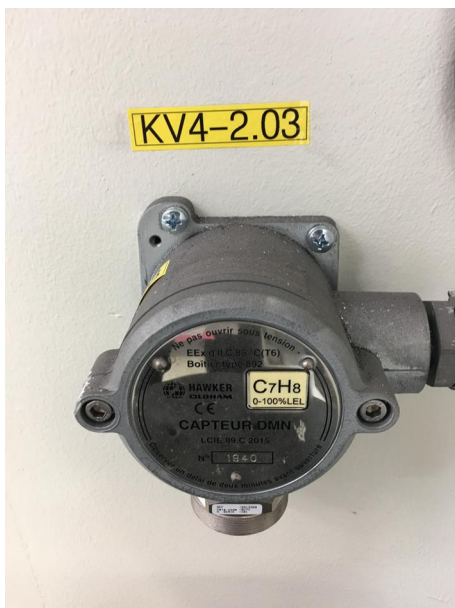
Kuva 5. Laite on varustettu numerotunnuksella, jonka perusteella se löytyy sähkökuvista.
