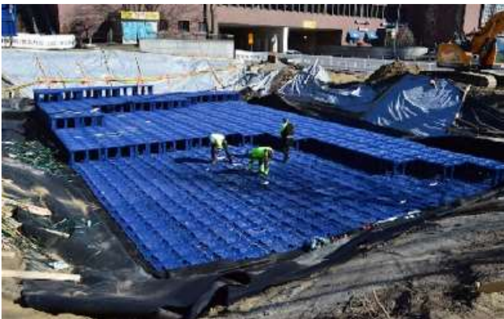
Kuva 10. Hulevesikasetit (Talotekniikka 2017).
