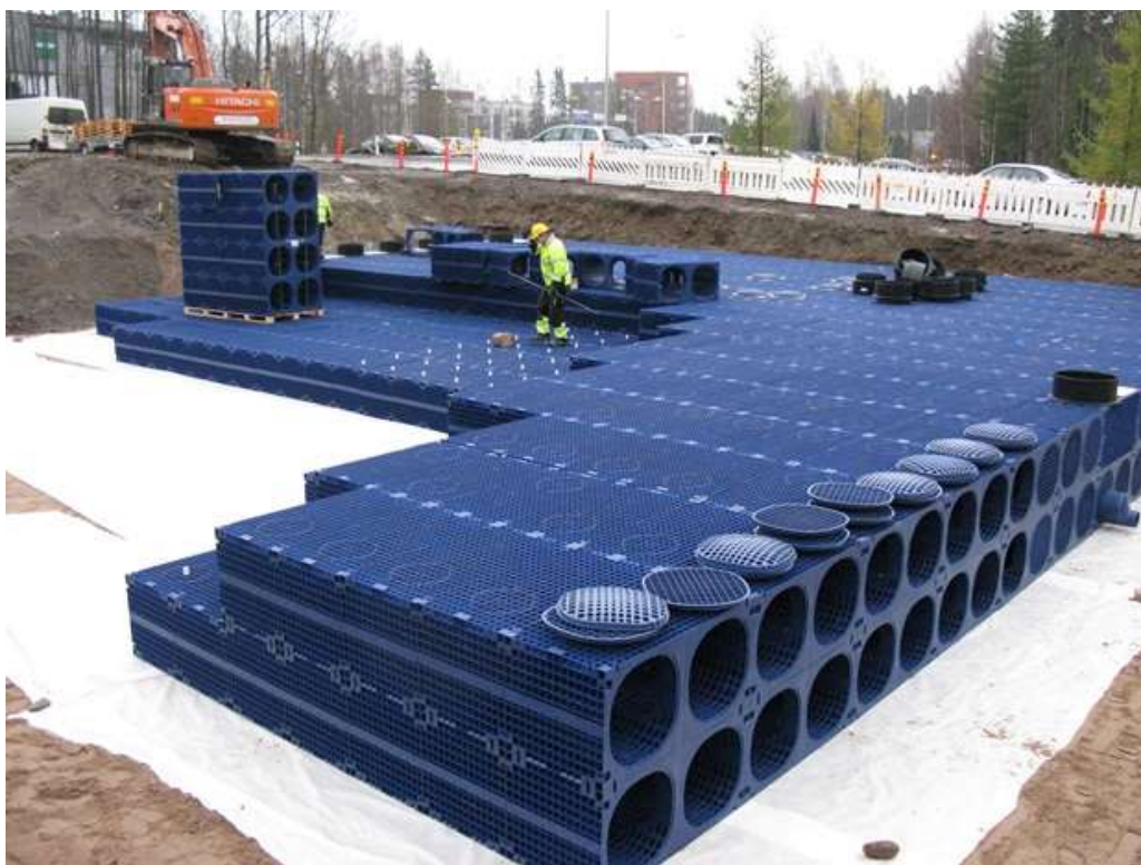
Kuva 15. Hulevesikasetit Tampereen Kaupin alueella (Wavin Labko 2018).
