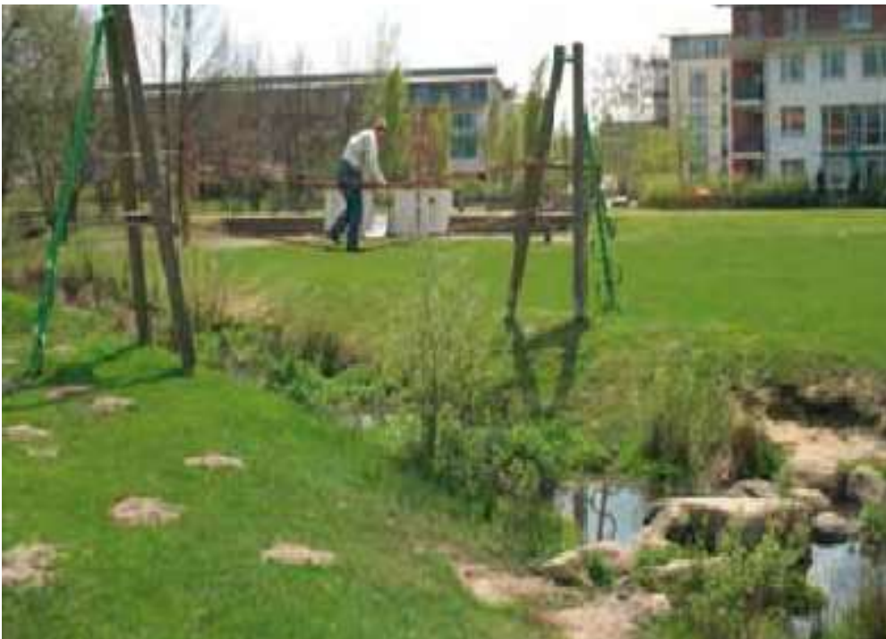
Kuva 8. Rakennettu puro (Kuntaliitto 2012).
