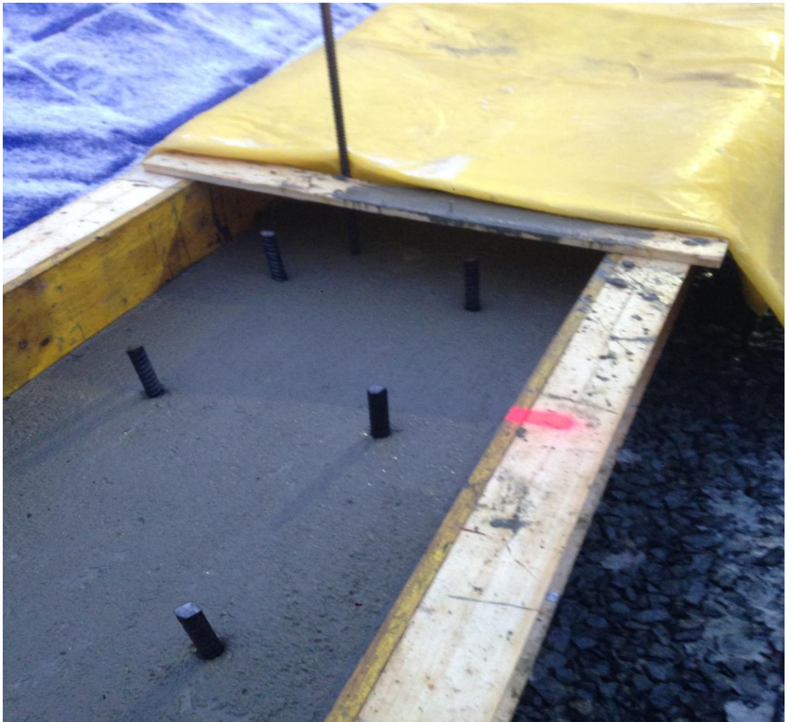
KUVA 2. Anturavalun peittäminen routamatolla.
