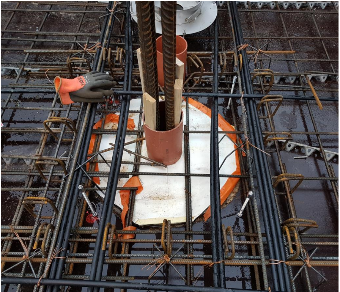
Kuva 2. Pilarin alueen raudoitusta. Valokuva: Atte Heiskanen
