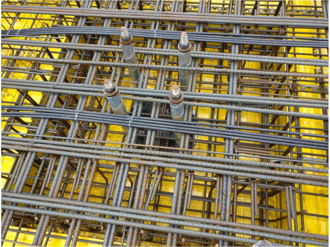
Kuva 28. Lävistysvahvikkeellinen muotti sekä pilarin alueen raudoitusta. Valokuva: Jonas Heikkilä
