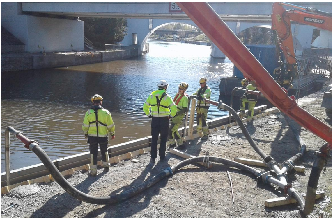
KUVA 18. Contractor-menetelmällä valaminen valuputkia käyttäen
