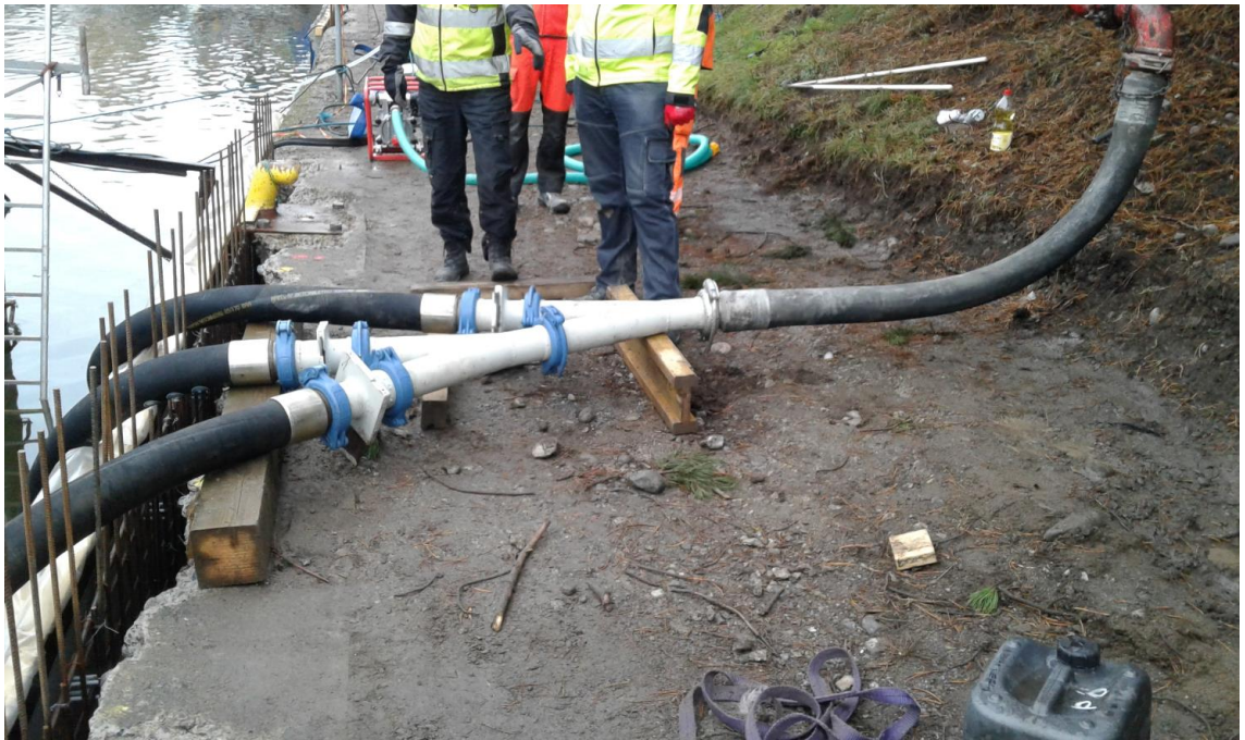
KUVA 17. Betonin pumppauksen jakotukki
