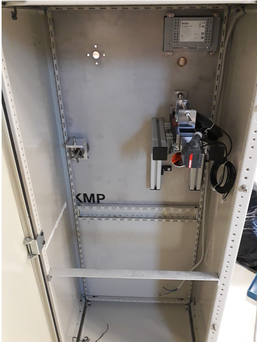
Figur 8. De gamla komponenterna borttagna. Spridarservo, HMI och pulsgivare monterade
