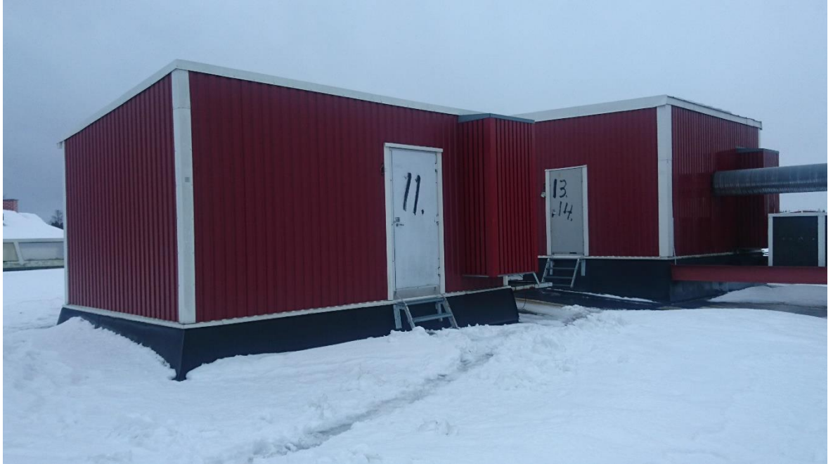
Kuva 1. Konehuoneet kuvattuna ulkopuolelta.
