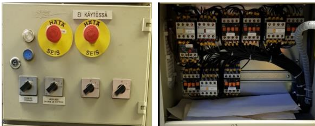
Kuva 11. Hätä-seis-kaappi RK0.3.
