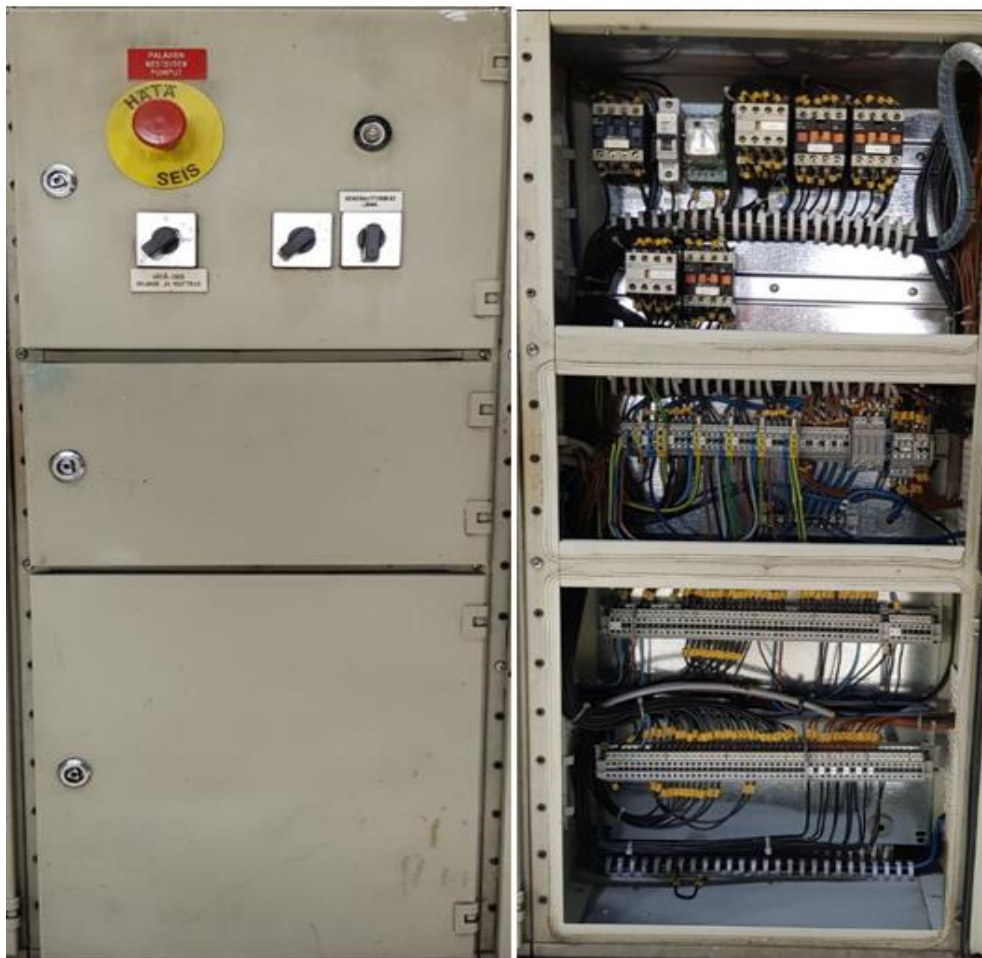
Kuva 7. RK1.2 Häätä-seis releet, riviliittimet ja häätä-seis-painike sekä kuittausvipu.
