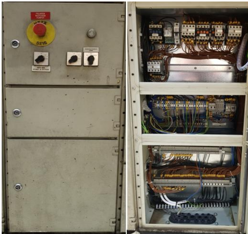
Kuva 6. RK1.1 Häätä-seis releet, riviliittimet ja häätä-seis-painike sekä kuittaus vipu.
