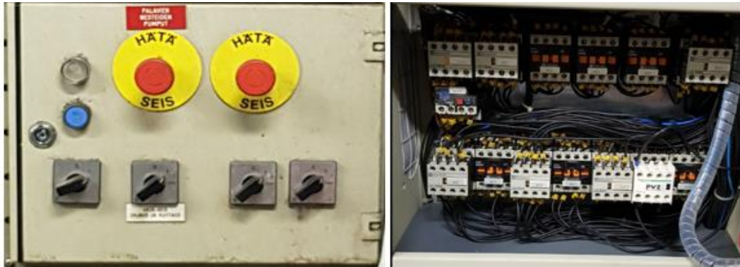
Kuva 9. RK0.2-hätä-seis-painikkeet sekä releet.
