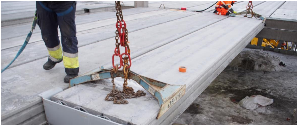
Kuva 20. Ontelolaatan nostosakset. Kuva: Sami Kotilainen 2017.
