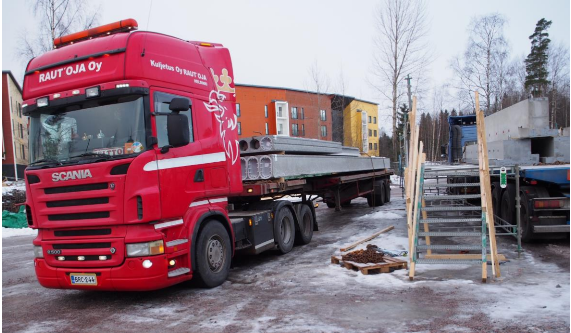
Kuva 19. Työskentelytaso elementtien purkua varten. Kuva: Sami Kotilainen 2017.
