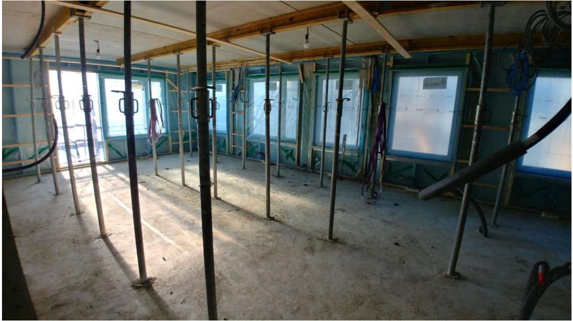
Kuva 15. Työnaikainen tuenta. Kuva: Sami Kotilainen 2018.
