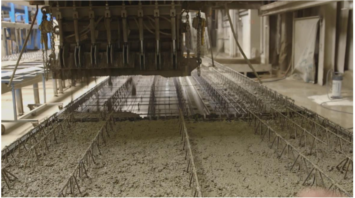
Kuva 7. Filigran-elementtien betonointi. Kuva: Samuli Nylander 2018.
