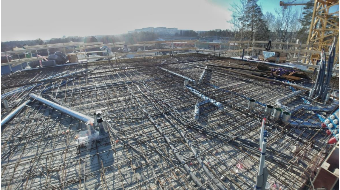
Kuva 14. Betonointia odottava välipohja. Kuva: Sami Kotilainen 2018.
