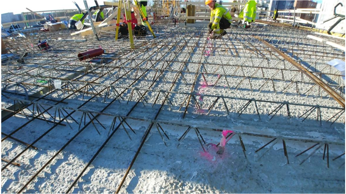
Kuva 13. Filigran-elementin alapinnan raudoitus. Kuva: Sami Kotilainen 2018.
