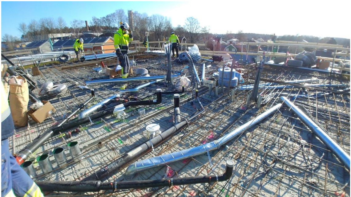
Kuva 9. Filigran-välipohja. Kuva: Sami Kotilainen 2018.
