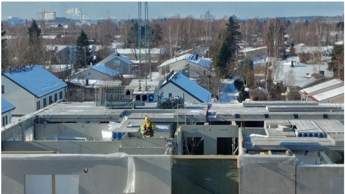
Kuva 21. Kavennetun ontelolaatan nosto. Kuva: Sami Kotilainen 2018.
