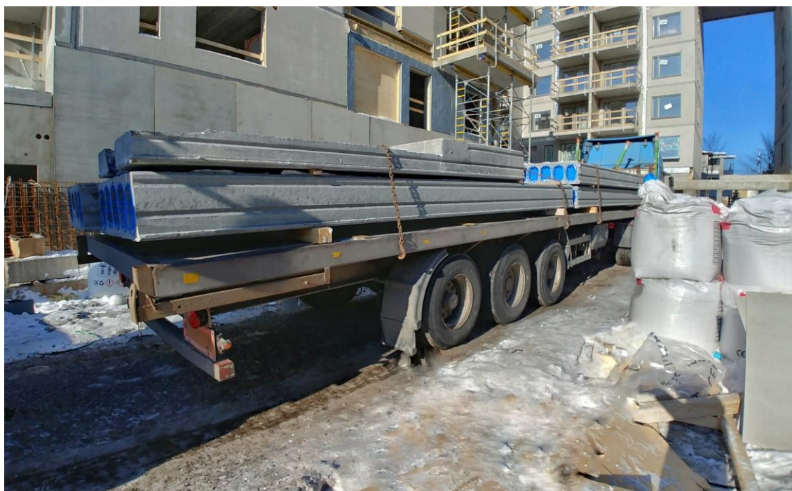
Kuva 18. Elementtien toimitus autokuljetuksella. Kuva: Sami Kotilainen 2018.
