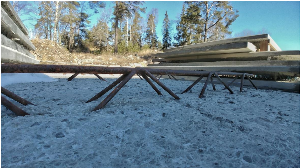
Kuva 5. Filigran- laatan ansaat. Kuva: Sami Kotilainen 2018.
