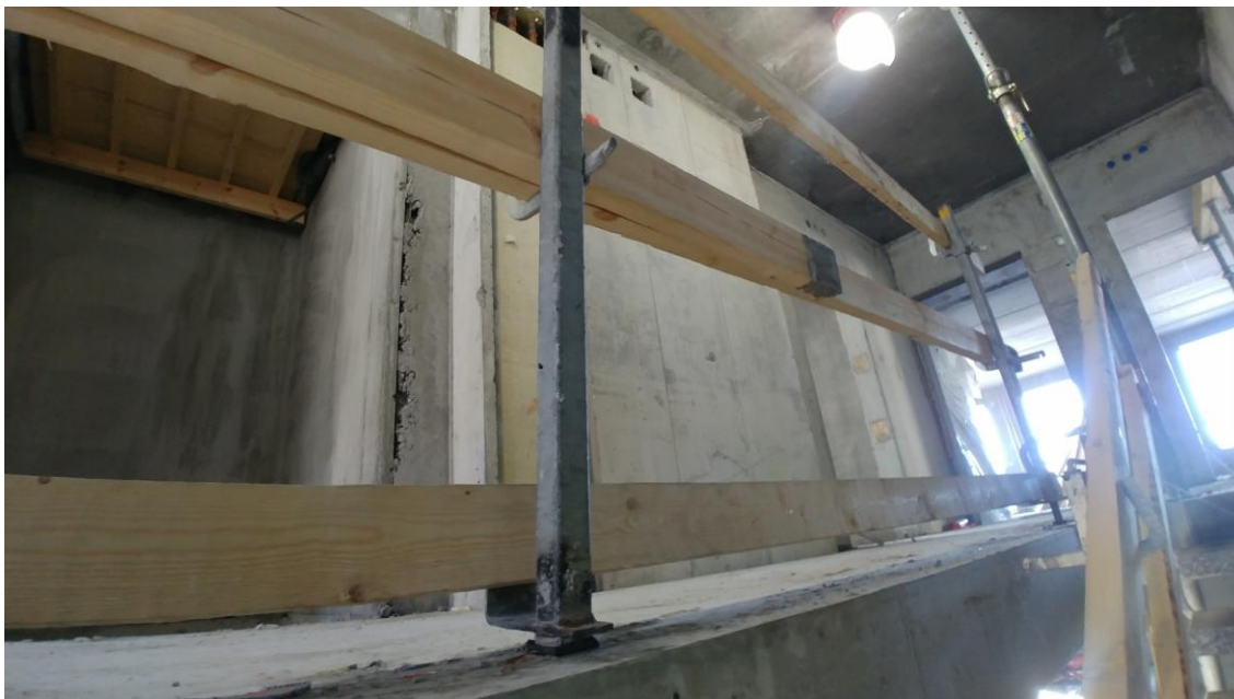
Kuva 23. Holkkiasenteinen kaide. Kuva: Sami Kotilainen 2018.
