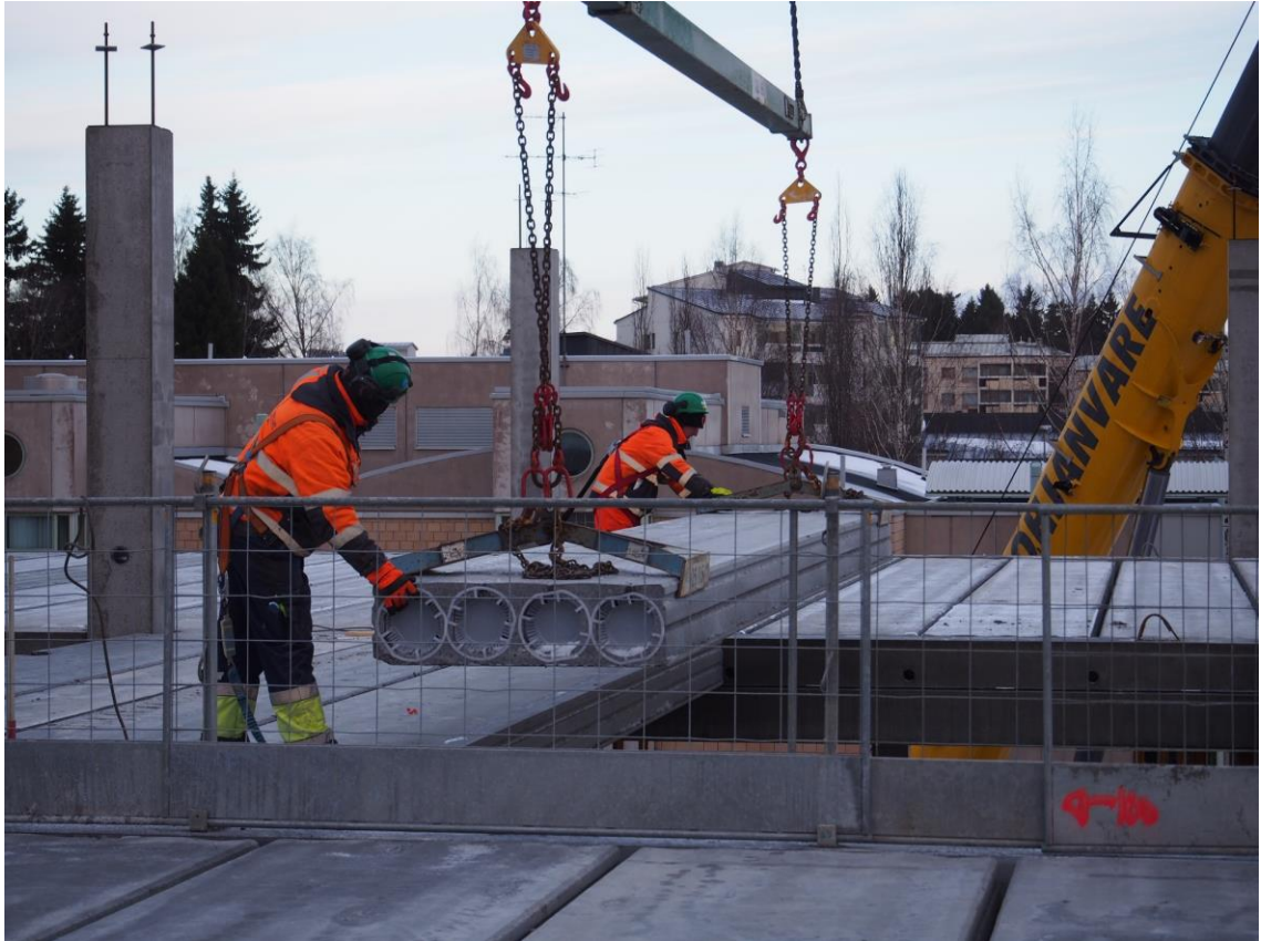
Kuva 22. Ontelolaatan asennus. Kuva: Sami Kotilainen 2017.
