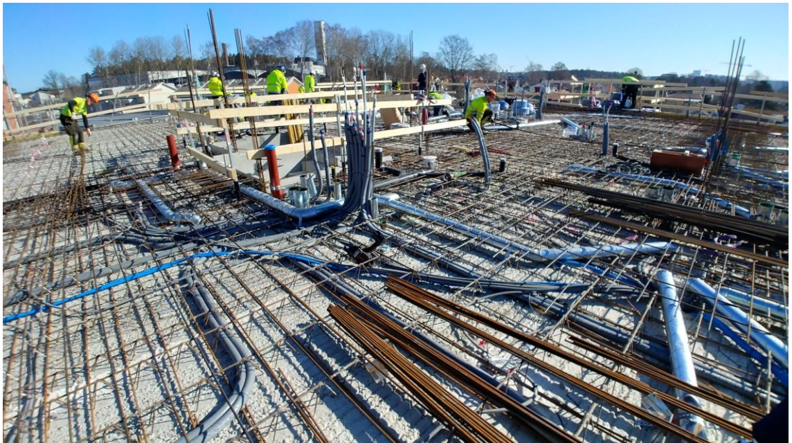
Kuva 24. LVIS-tekniikka asennettuna filigran-välipohjarakenteeseen. Kuva: Sami Kotilainen 2018.
