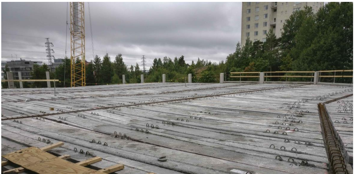
Kuva 2. Kuorilaatat asennettuna. Kuva: Sami Kotilainen 2017.
