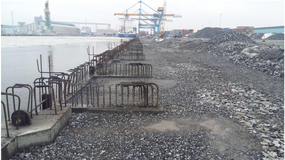
KUVA 2. Kulmatukimuurilaiturin perustukset, jossa kulmatuki- sekä saumaelementit asennettu ja taustatäyttö tehty
