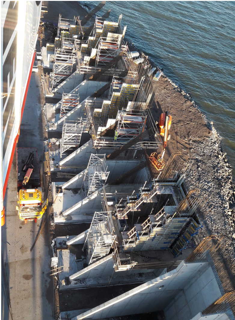
KUVA 14. Toisen kerroksen muotteja valmiina valuun sekä raudoitukseen
