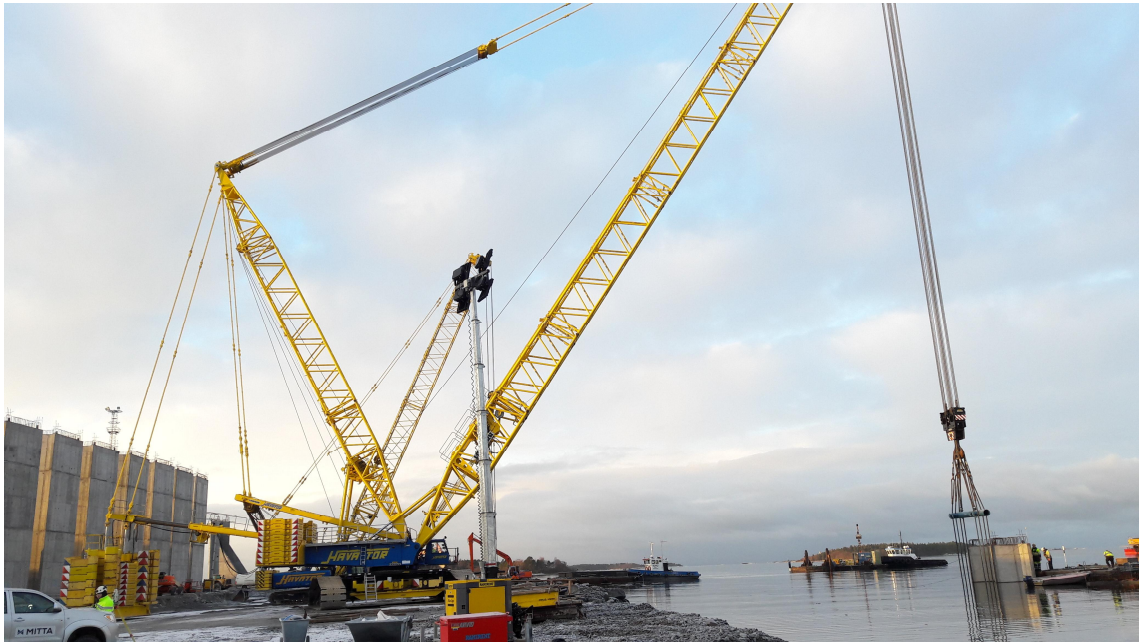
KUVA 19. Kulmatukielementin asennus käynnissä
