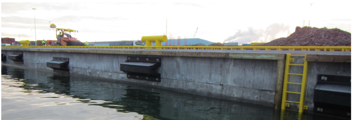
KUVA 7. Valmista ja varusteltua reunamuurilaituria
