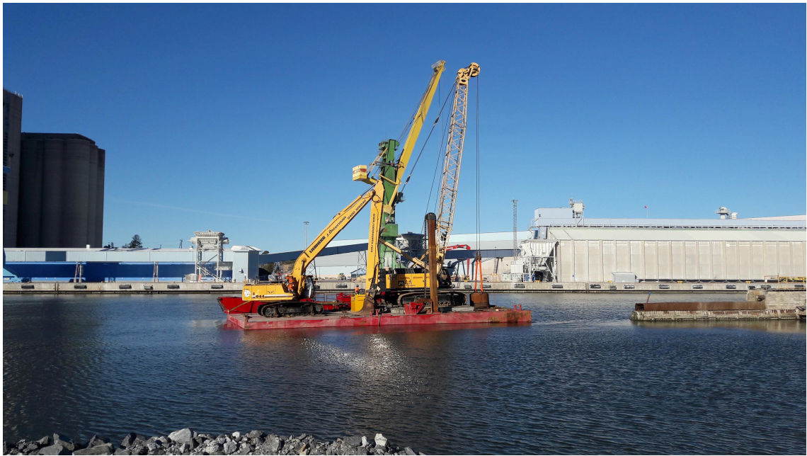
KUVA 3. Elementtien asennuspohjan syvätiivistys alkamassa
