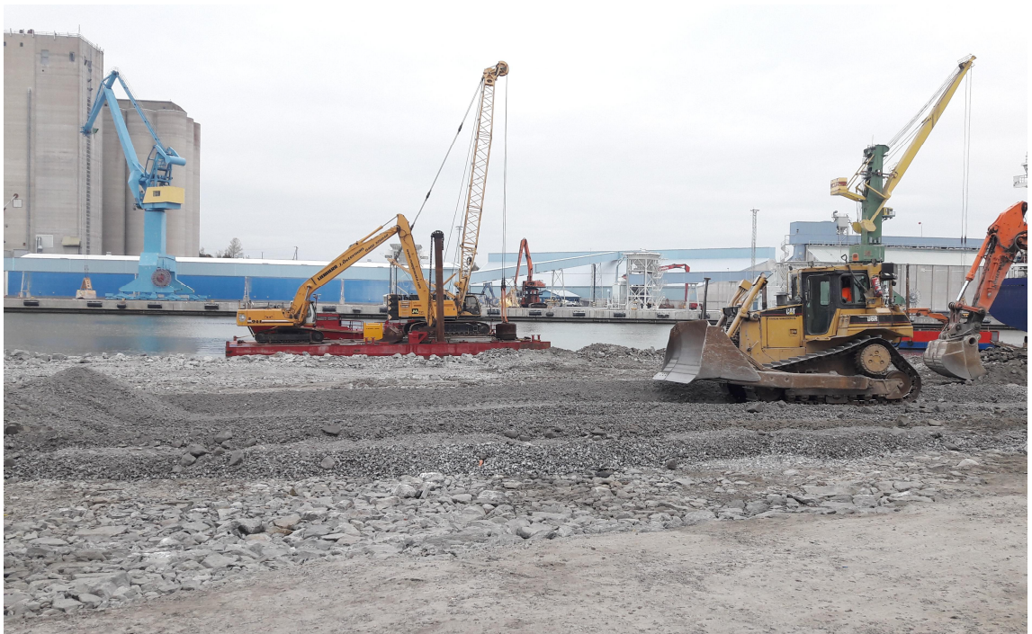
KUVA 5. Taustatäytön ajoa sekä elementtien asennuspohjan syvätiivistystä kaivuulautalta
