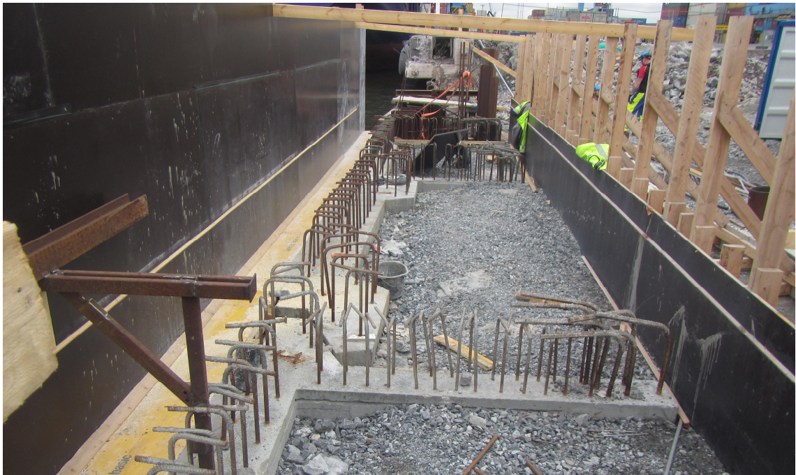
KUVA 4. Reunamuurin muottirakenteita pohjalaatan tulevia työvaiheita varten
