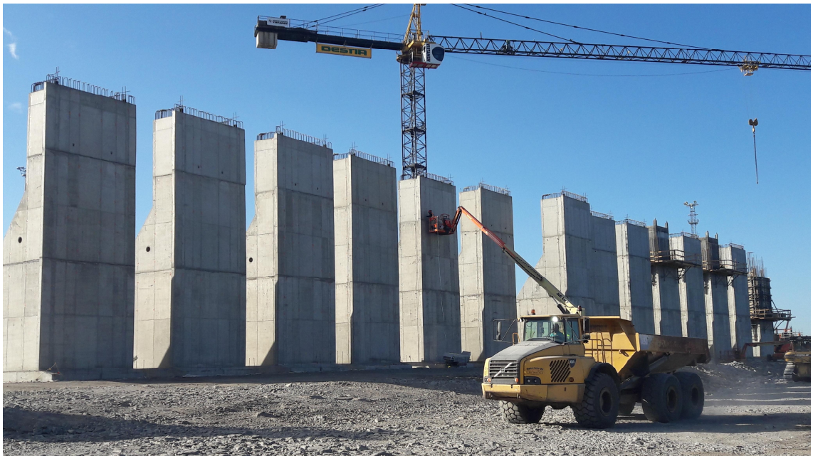
KUVA 12. Valmiita elementtejä viimeistelyvaiheessa sekä toisen- ja kolmannen kerroksen muotteja työtasoinen asennettuna
