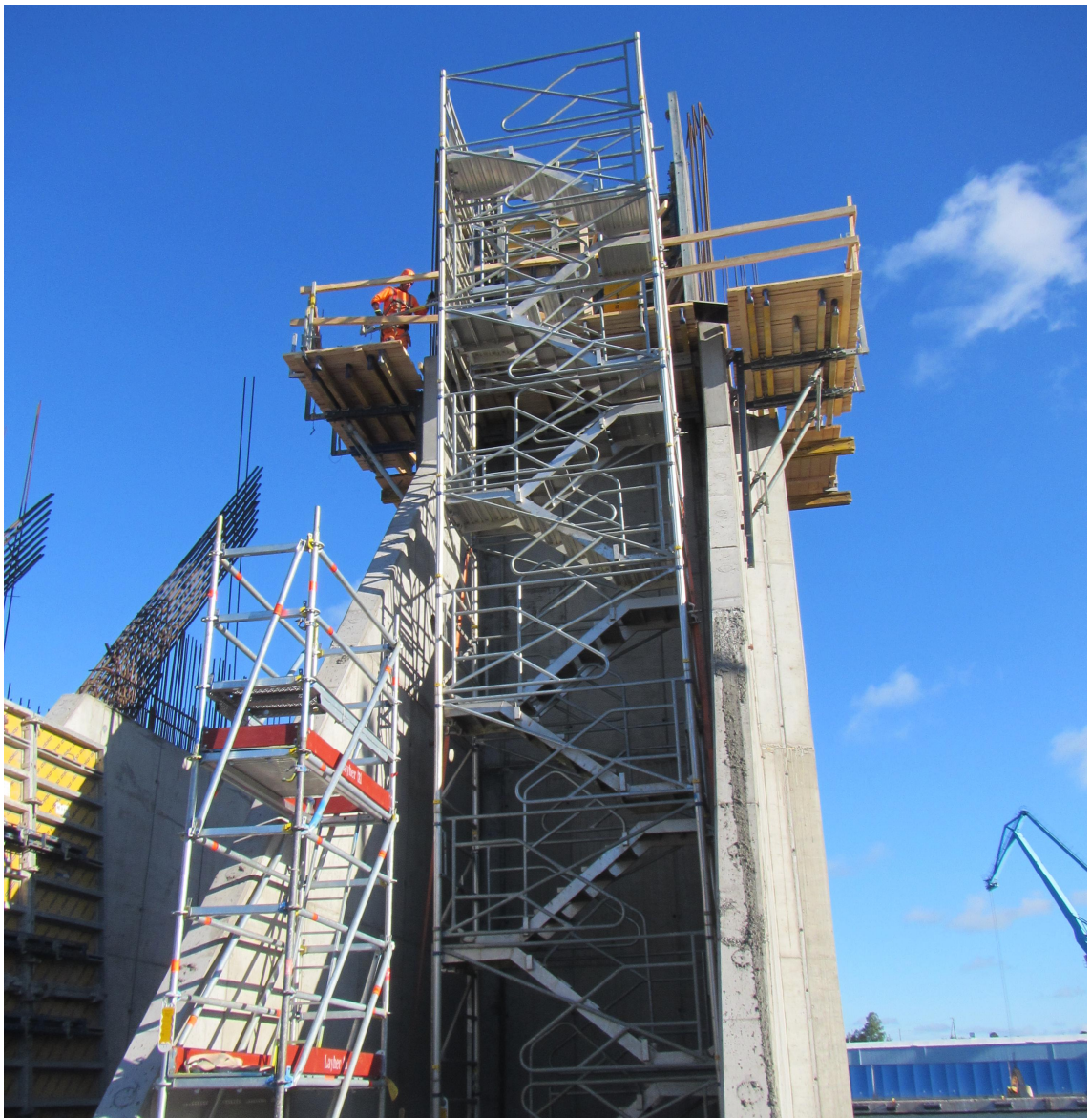
KUVA 11. Kolmannen kerroksen sisäsielu sekä kulku- ja työtelineet valmiina seuraavaan työvaiheeseen
