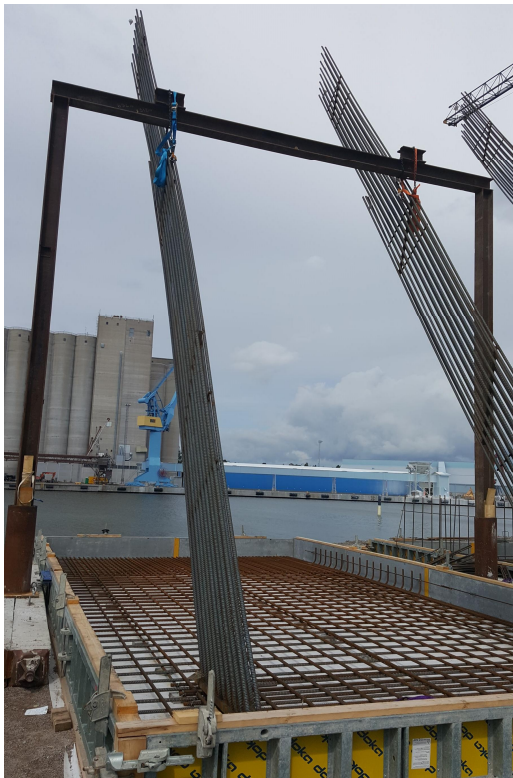
KUVA 8. Pohjalaatan muotti ja riparaidoitteet valmiina
