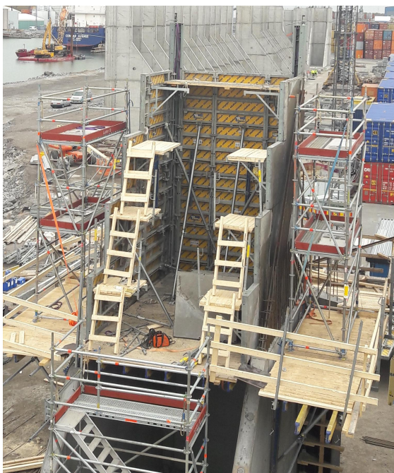
KUVA 10. Toisen kerroksen sisäsielu ja työtasot lähes valmiina raudoitukselle
