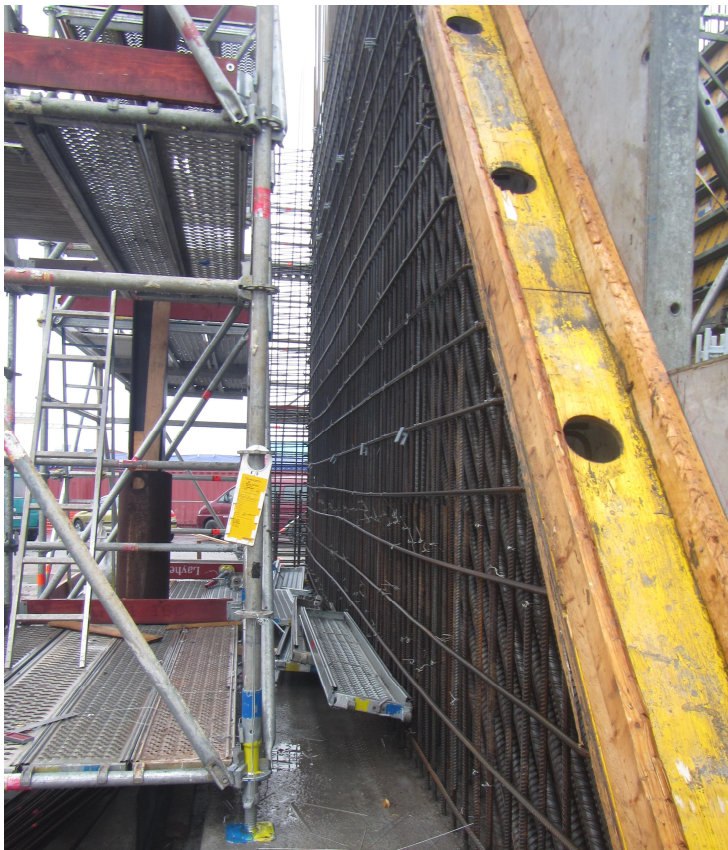
KUVA 17. Ensimmäisen kerroksen muotin tuplaus aloitettu asentamalla siipimuurin päälimuotti, jossa reiät betonin pumppausta ja tiivistystä varten
