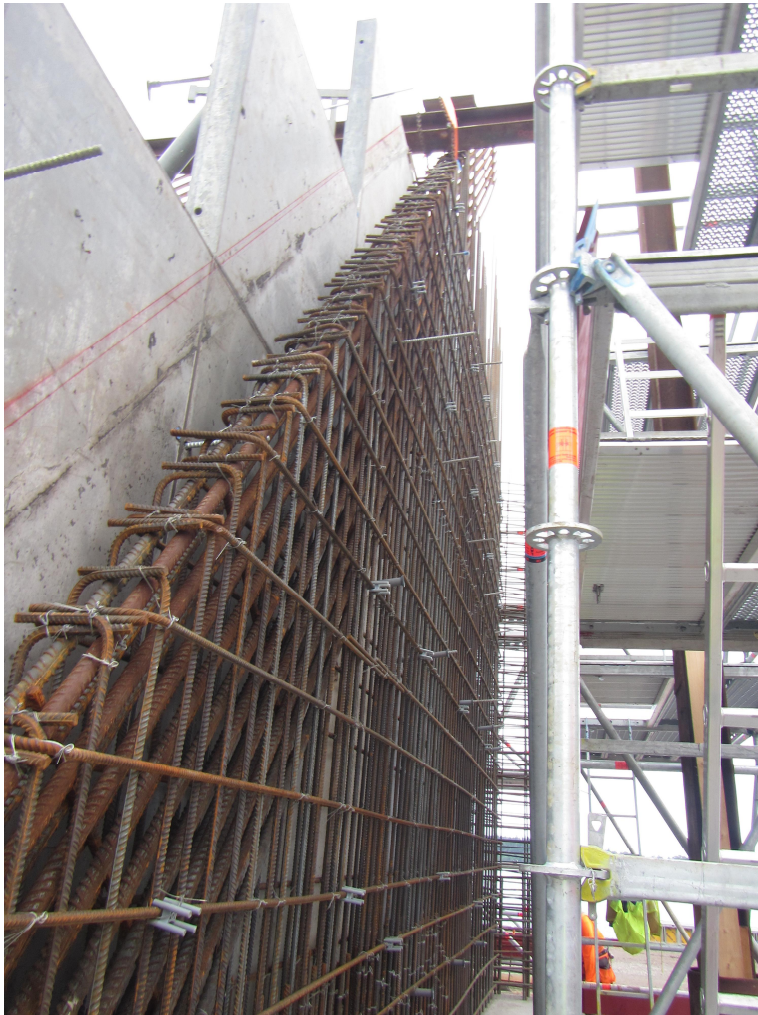
KUVA 15. Ensimmäisen kerroksen valmis siipimuuriraidoite
