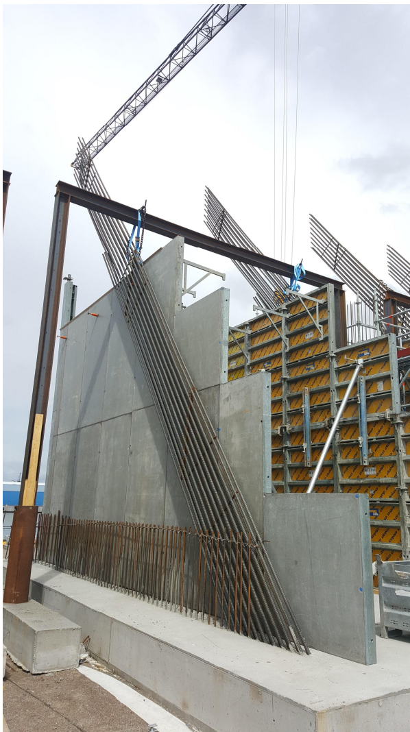
KUVA 9. Ensimmäisen kerroksen sisäsielu asennettuna ja valmiina raudoitukselle
