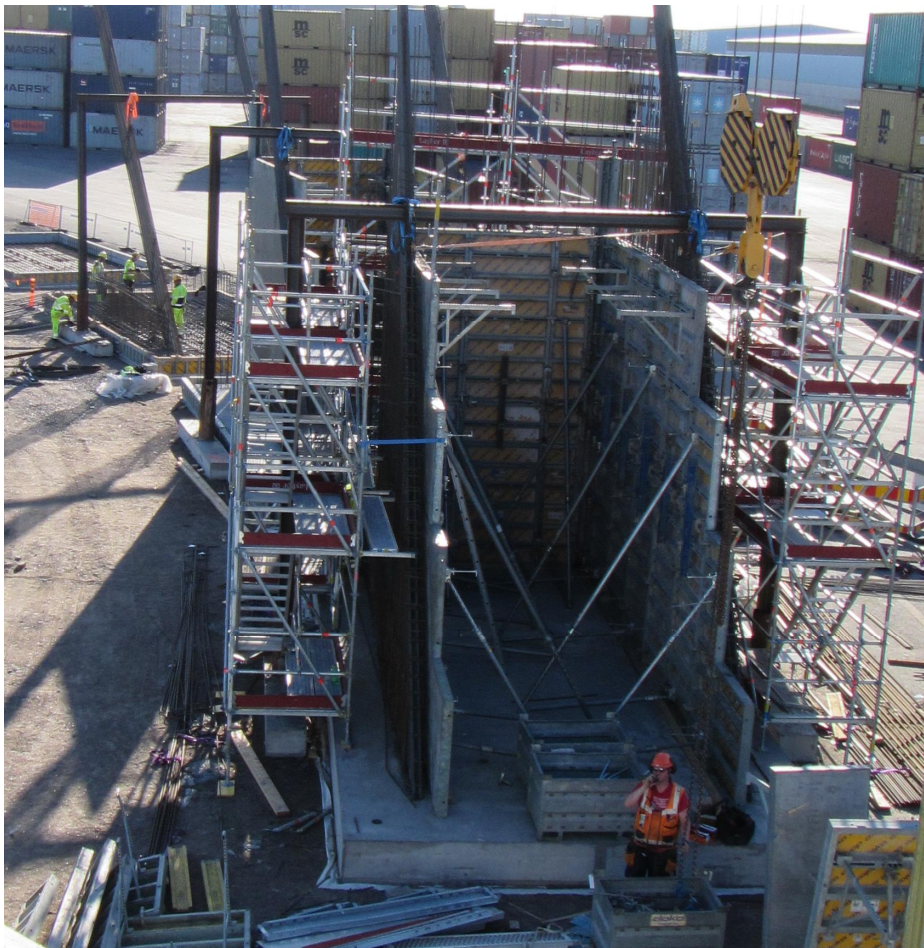
KUVA 13. Ensimmäisen kerroksen työtelineet valmiina raudoitustyöhön
