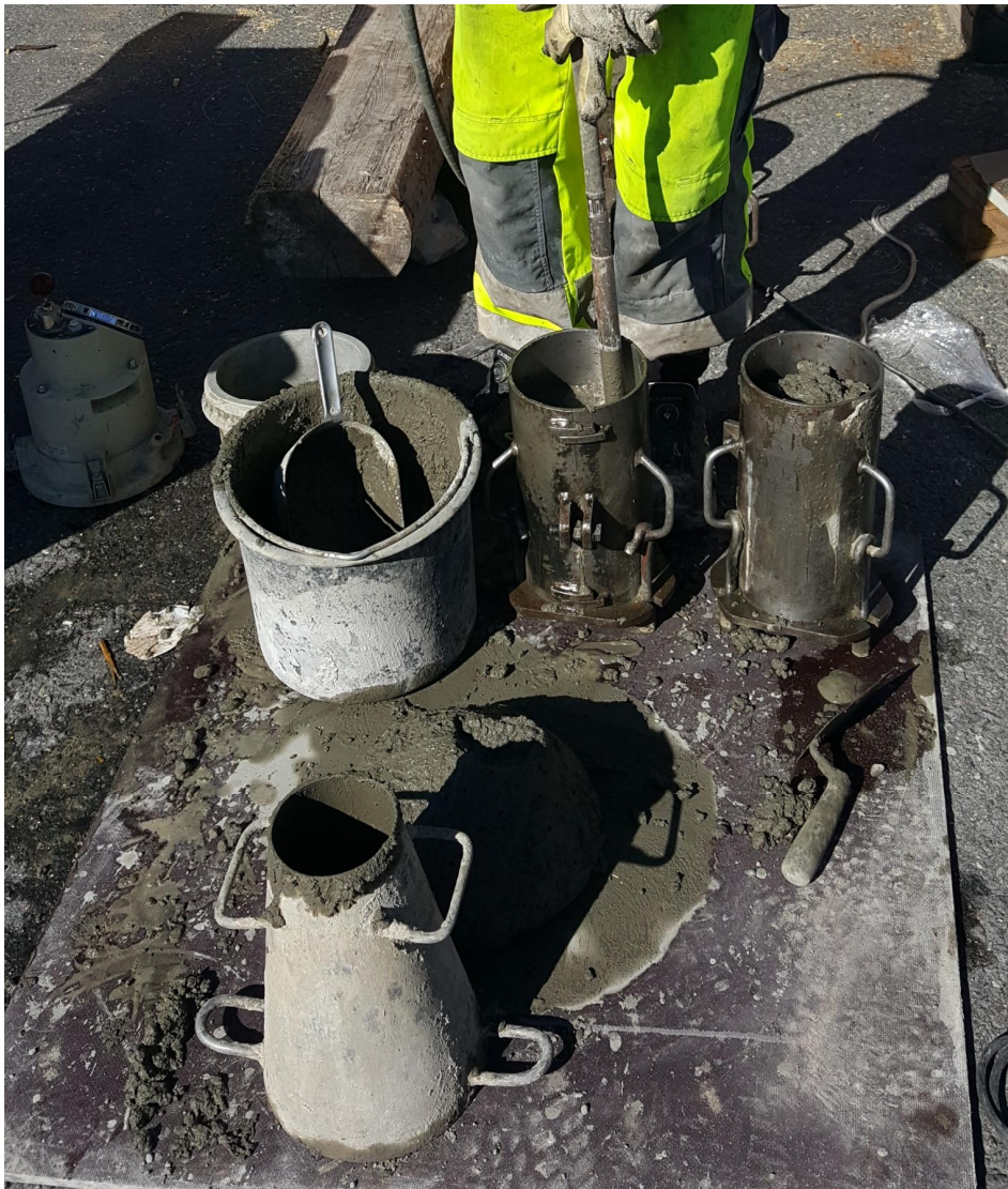
KUVA 16. Betonimassan laadunvalvontaa työmaalla painuma- ja ilmamäärätestein sekä olosuhdekoekappaleiden ottamista puristuslujuuskokeisiin
