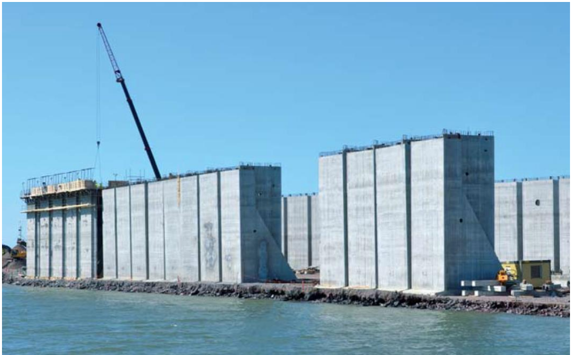
KUVA 6. Liukuvalettuja kulmatuki- ja saumaelementtejä (Terramare Oy:n tiedotuslehti, 2012, 8, muokattu)
