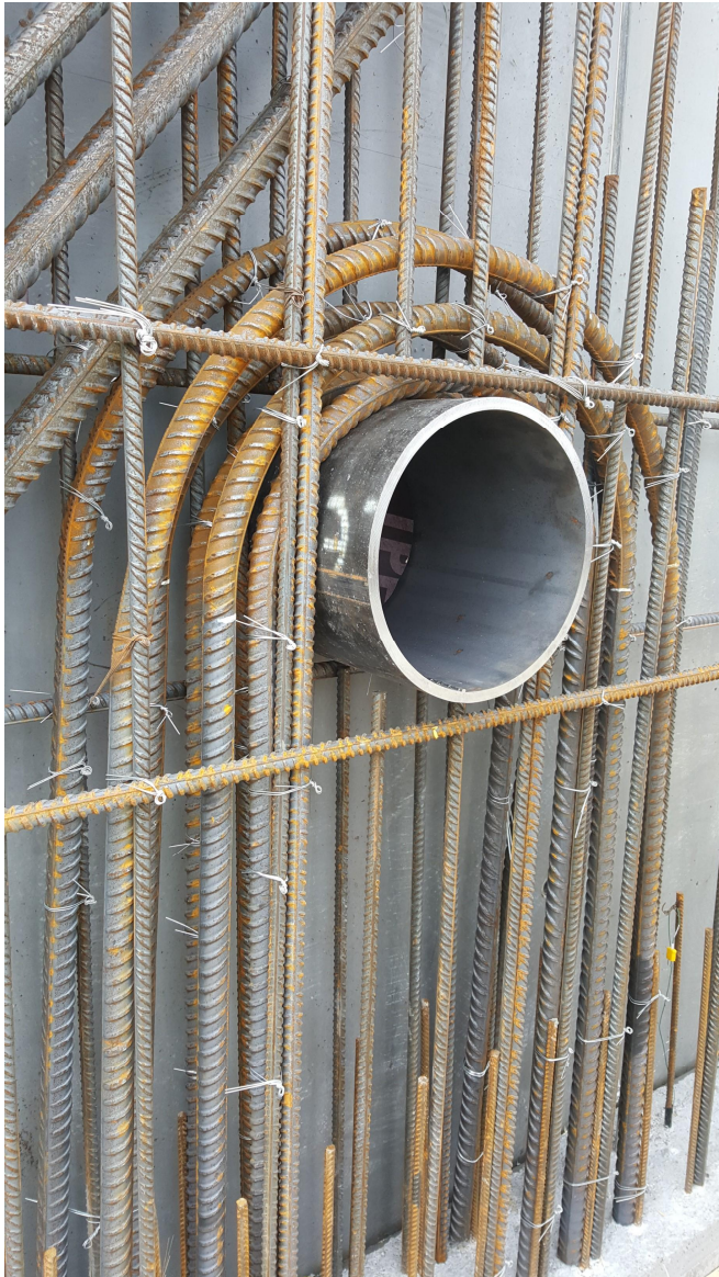
KUVA 18. Toisen kerroksen raudituskuva jossa nostosylinteri asennettuna
