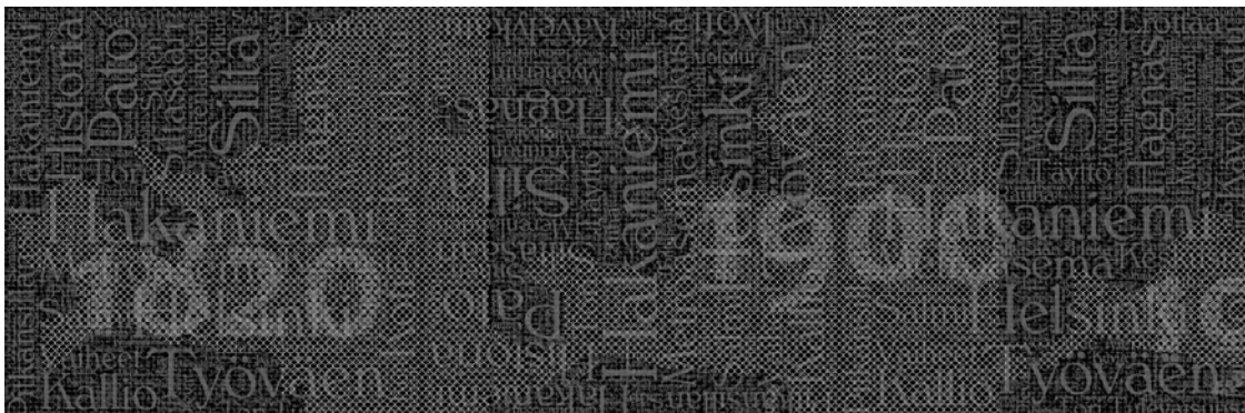
KUVA 44. Kuvassa graafisella betonilla tehtyjä kuva-aiheita rantabulevardin liiketilojen seinissä, jotka kuvaavat rantaviivan muuttumista ja alueen historiallisia tapahtumia.
