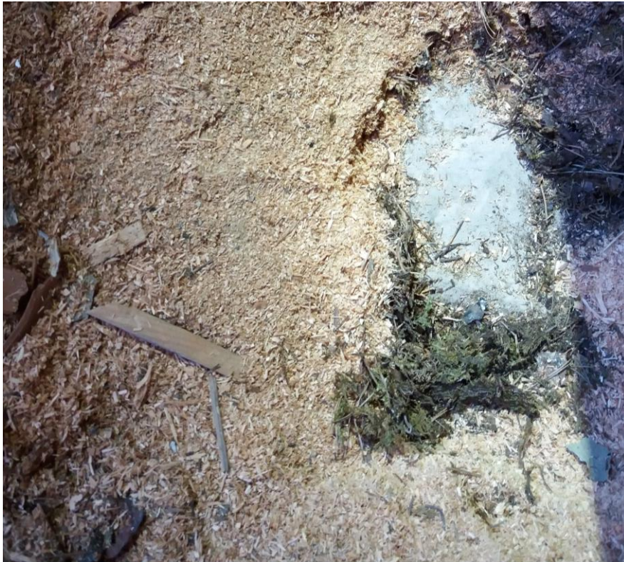
Kuva 19. Rakenneavauksissa yläpohjasta löydetyt eristekerrokset.
