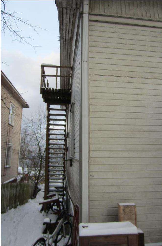
Kuva 22. Kohderakennuksen länsipääty ja naapurikiinteistö.
