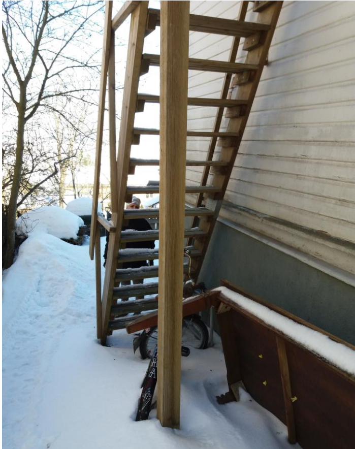
Kuva 16. Ullakolle johtava jyrkkä ulkoporras ja sitä tukeva pilari.
