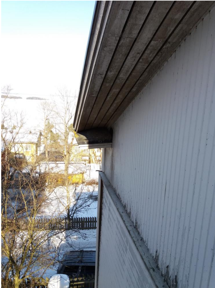
Kuva 30. Liittyvien ulkoseinäverhousien ulkopintojen suhde toisiinsa sekä räystään alapuolinen harvalauditus.
