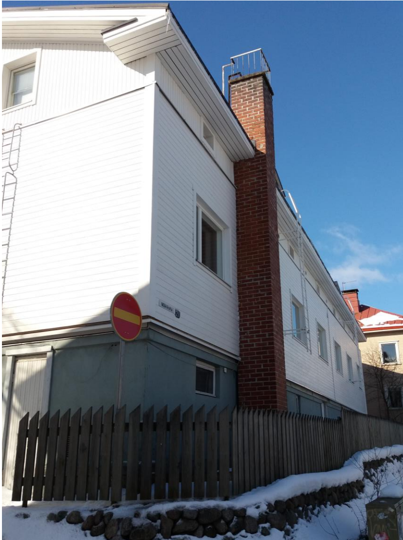
Kuva 9. Rakennuksen räystään kulmassa oleva kissapenkki.
