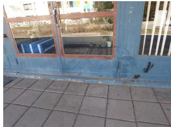
KUVA 17. Teräskarmiset ovet
