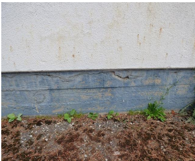
KUVA 2. Halkeamat kivijalassa
