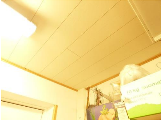
KUVA 25. Kylmähuoneen katon panelointi
