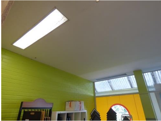
KUVA 30. Varastona toimivan tilan seinä
