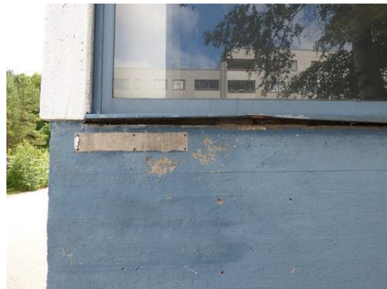
KUVA 12. Pellin alta eristettä viety ja sähköjohto näkyvillä
