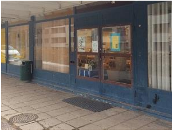
KUVA 13. Teräskarmiset ikkunat
