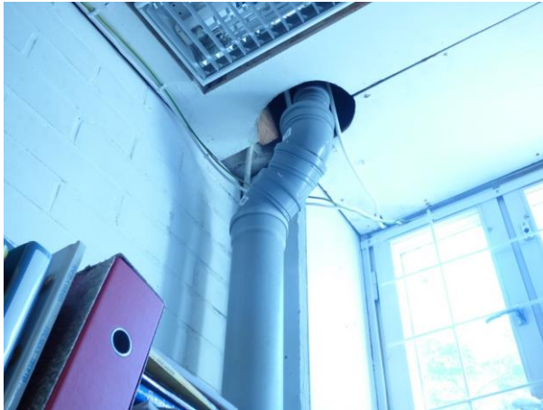
KUVA 35. Kattokaivon putki
