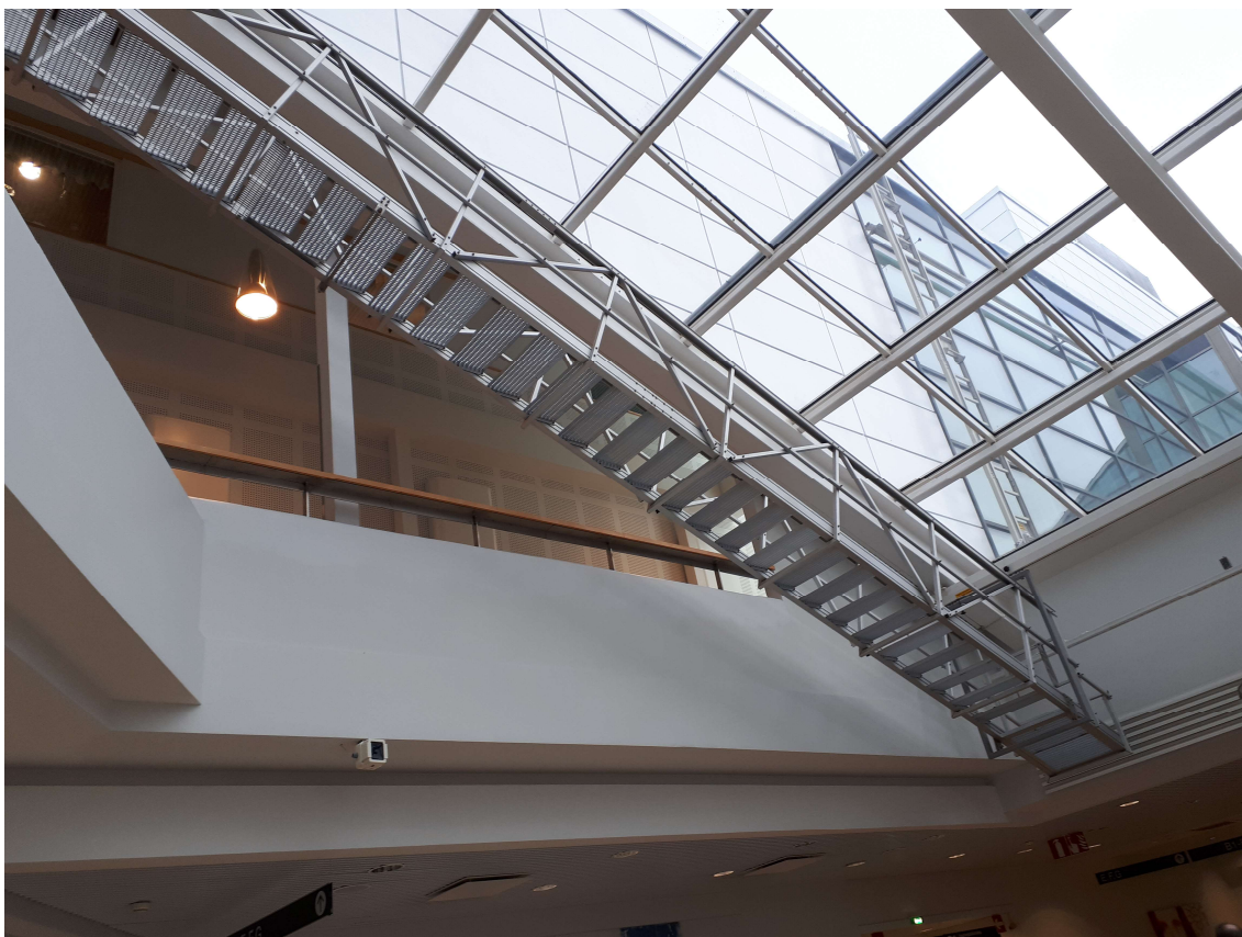
KUVA 14. Huoltosilta TYKS;in T- Sairaala (Flink 2018)
