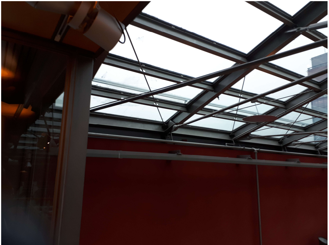
KUVA 19. Harjakaton jäykistys vetotankojen avulla (Flink 2018)
