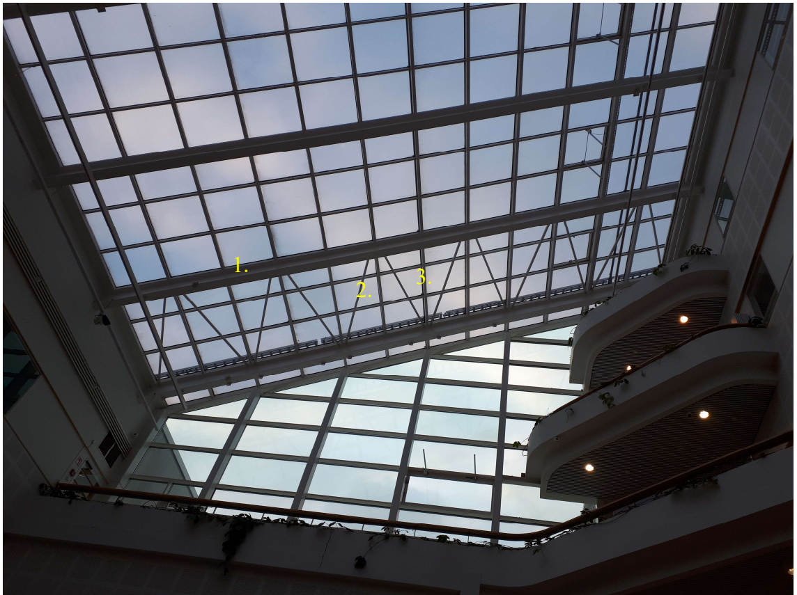
KUVA 18. Pulpettikaton jäykistys ristikko (Flink 2018)
