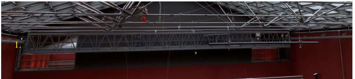
KUVA 13. Huoltosilta harjakatto (Flink 2018)
