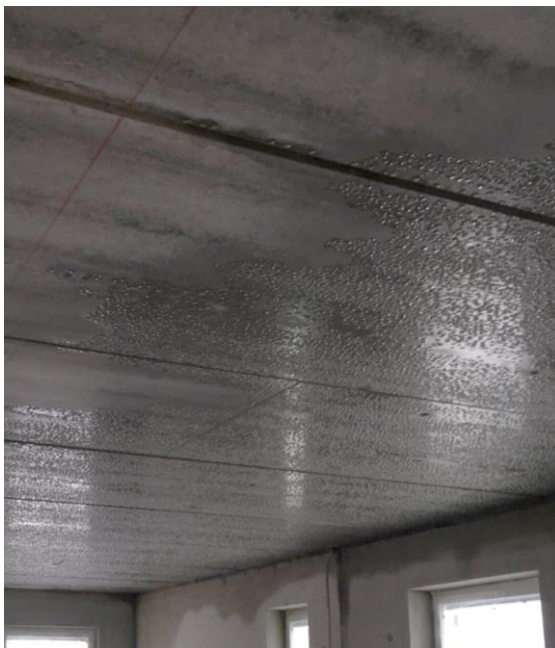
KUVA 6. Yläpohjan alapinta ennen puhaltimien asentamista
