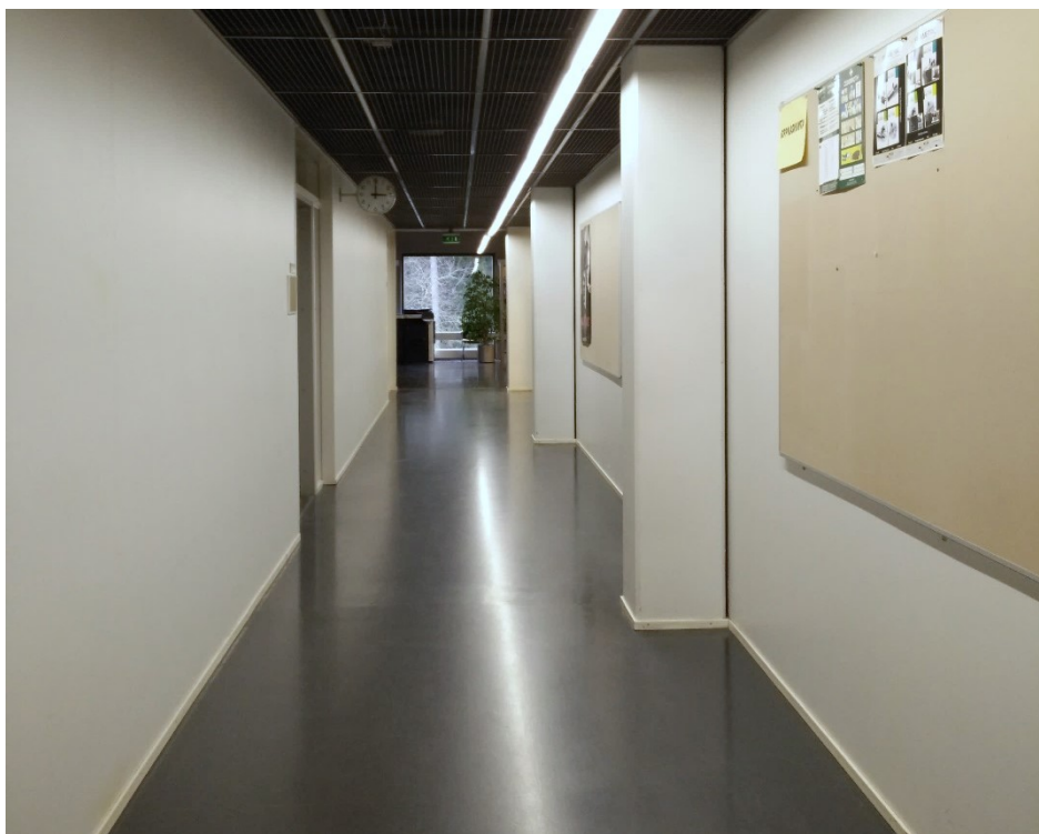
Kuva 6. D-siiven käytävä luokkatilan D208 ovelta katsottaessa.
