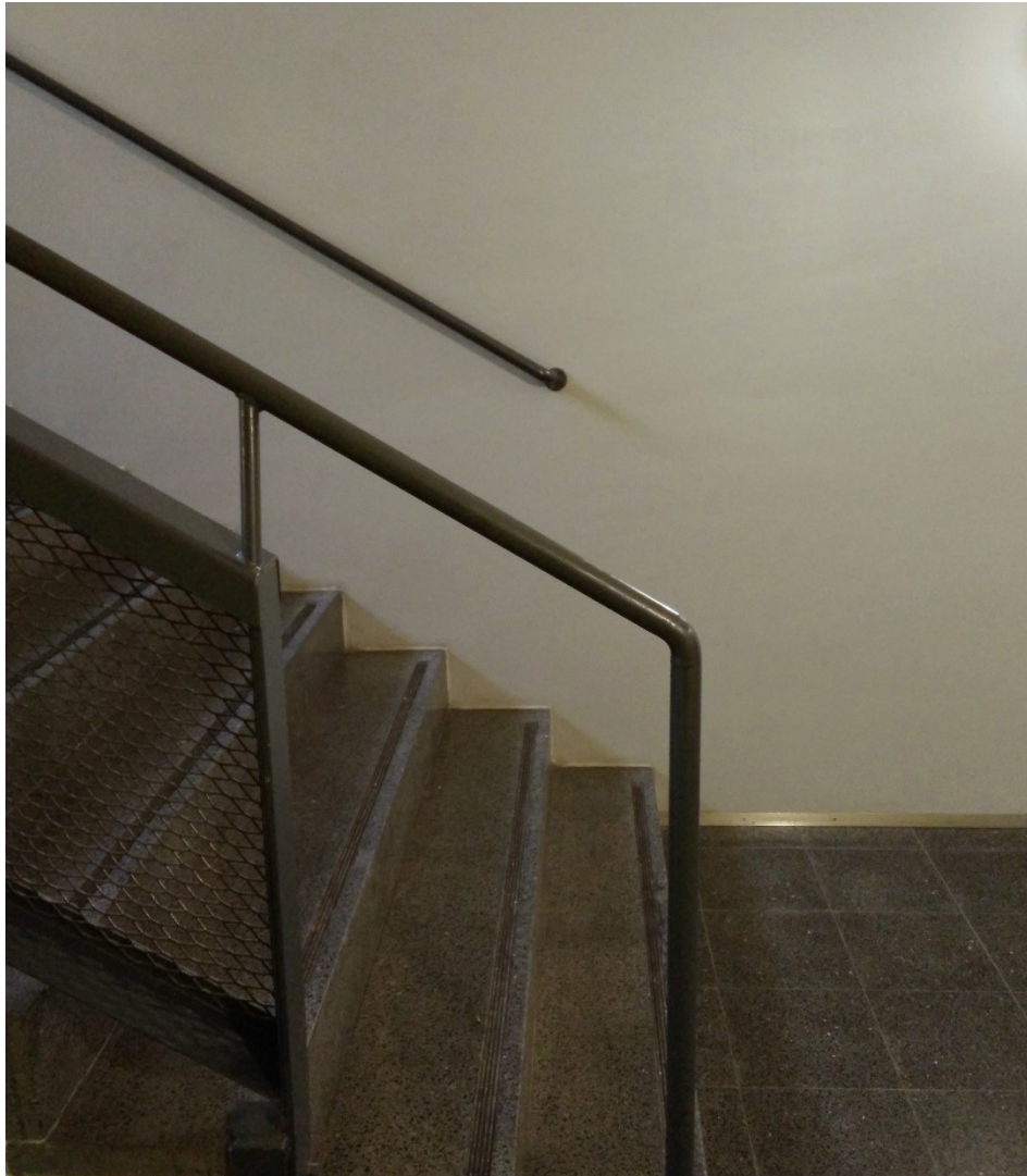
Kuva 24. D-siiven portaikon alapää, seinän käsijohde.
