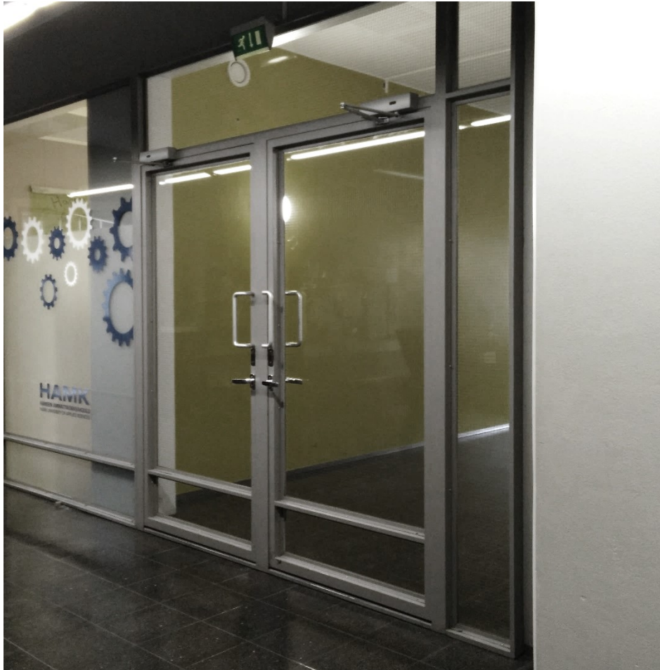
Kuva 7. D-siiven portaikon yläpää, pariovet.
