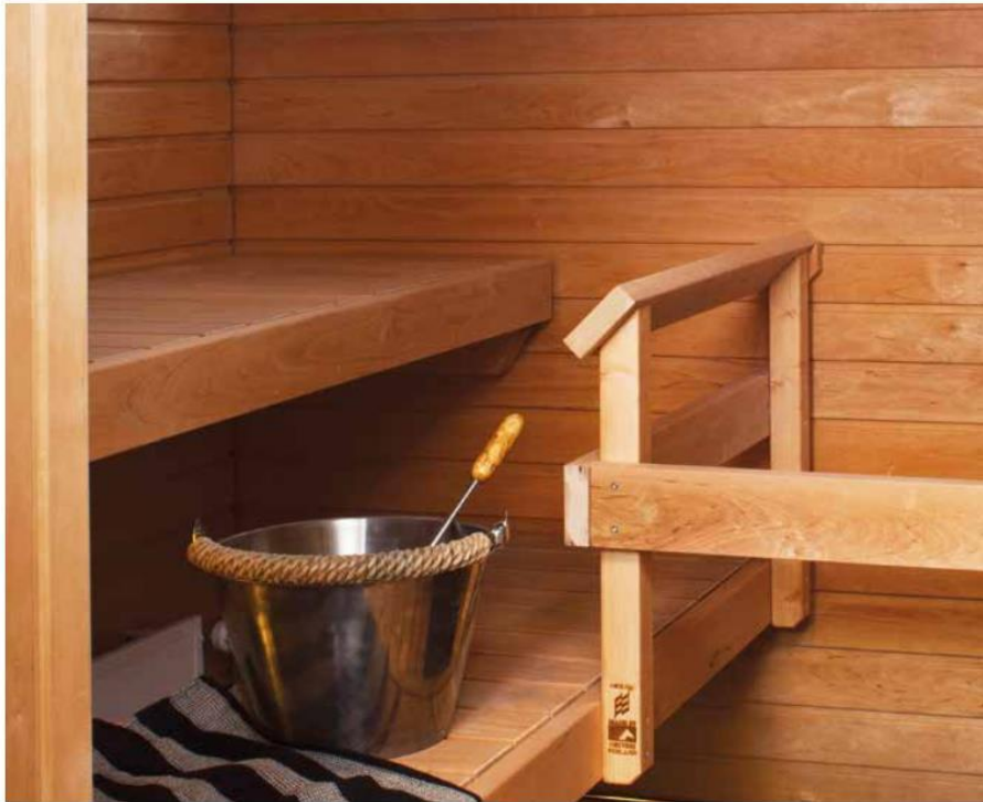
Saunan panelointi ja lauteet seinät ja katto tervaleppäpaneeli tervaleppälauteet, tukirakenne havupuuta
