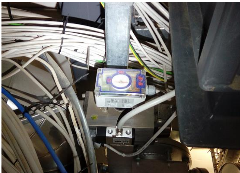
KUVA 18. HV-3071:n asennoitin ja rajatilakytkin. Magneettiventtiili käännetty fyysisesti toisinpäin ohjauksen muuttamiseksi.
