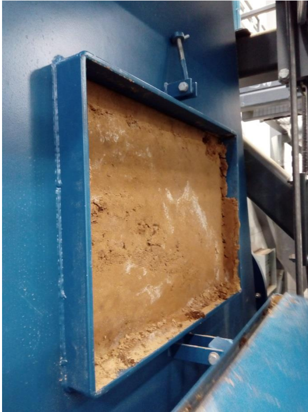
KUVA 46. Polttoainevälisiilon huoltoluukku. Lievää pakkaantumista havaittavissa.
