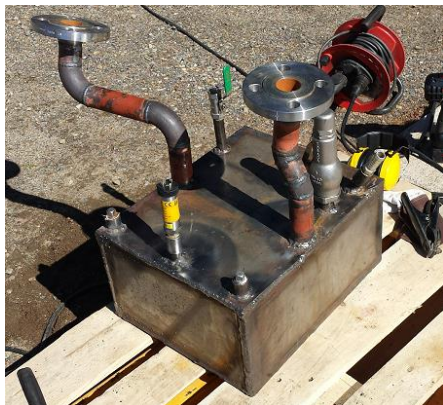
KUVA 9. Ammoniakkisäiliö korjaustöiden kohteena kesällä 2017.
