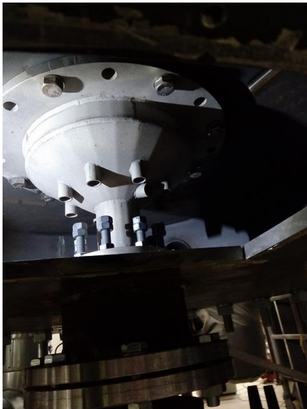
KUVA 6. Arina alhaaltapäin kuvattuna ilmalaatikon huoltoluukulta.
