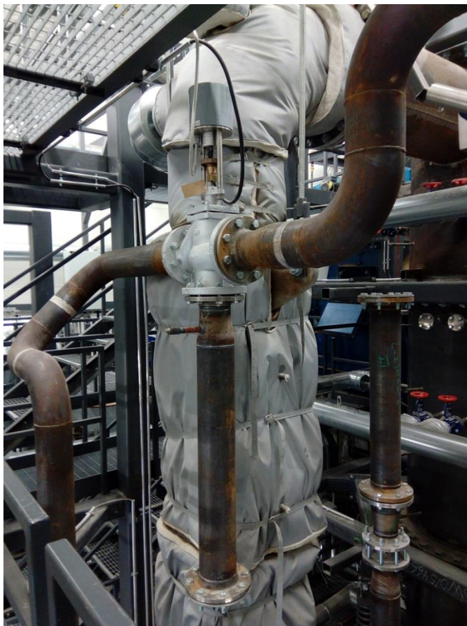
KUVA 32. TV-2004 3-tieventtiili. Asennoitin käännetty käsin sellaiseen asentoon, että ilmavirta pääsee kulkemaan ilmanjakotukkiin.
