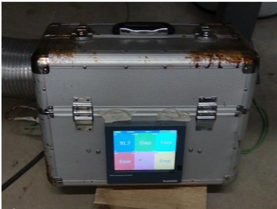
KUVA 47. Erillinen lämpötilamittaus kattilakeraamissa segmentissä a4.b.
