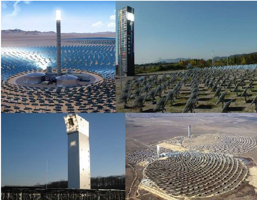
Kuva 15. Neljä tyypillisintä aurinkotornitekniologiaa. Ylhäällä vasemmalla ulkoinen sylinterikeräin, ylhäällä oikealla litteä keräin, alhaalla vasemmalla volymetrinen sekä oikealla tyhjiökeräin. /43/, /44/, /45/, /46/
