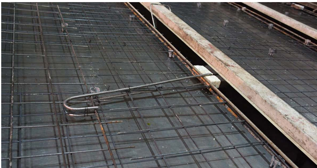
Kuva 9 Lietekuiluelementin nostolenkin raudoitus.
