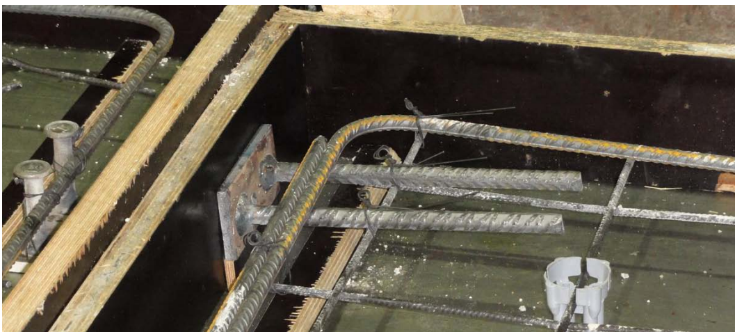
Kuva 8 KL-kiinnityslevyn raudoitus.
