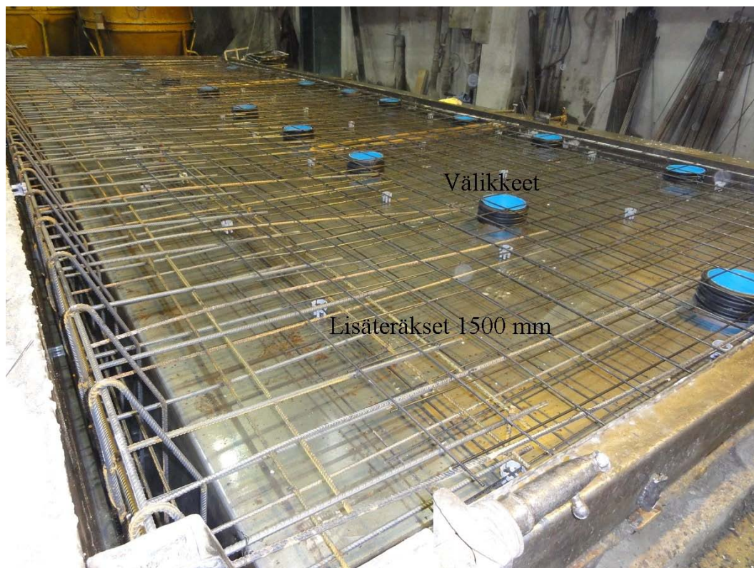
Kuva 2 Laakasiiloelementin raudoitus.
