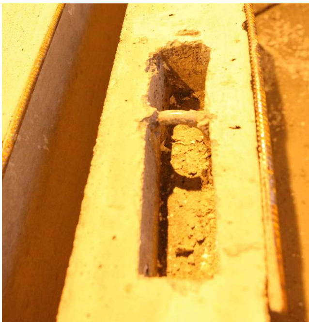
Kuva 10 Lietekuiluelementin nostolenkki valmiissa elementissä.
