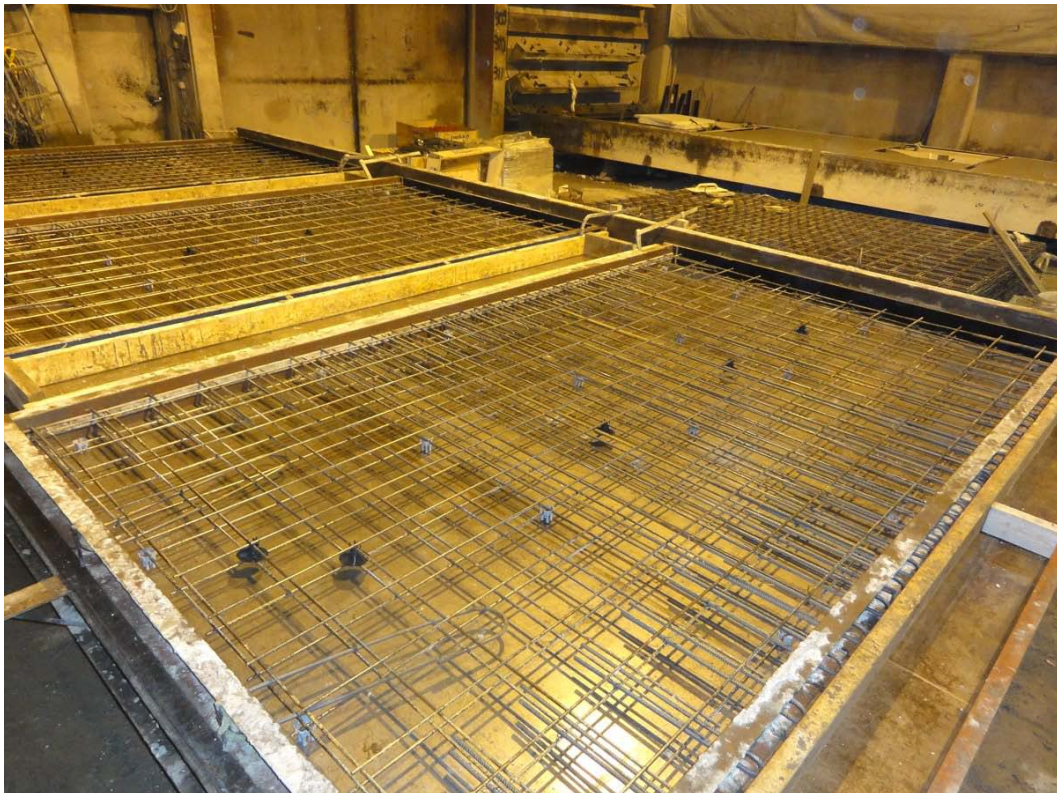
Kuva 12 Lietesäiliöelementin muotti ja raudoitus.
