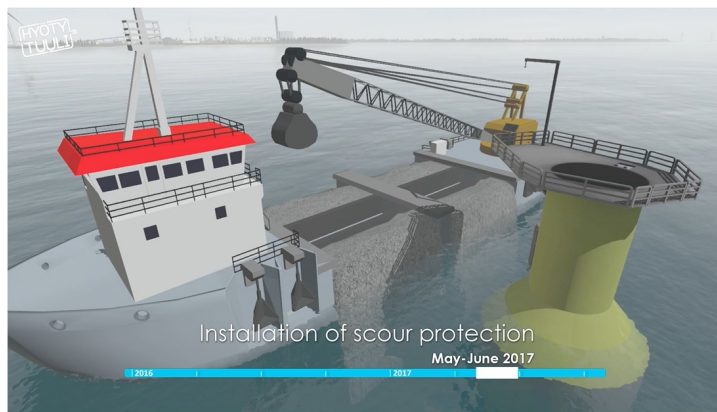
Picture 24: Installing scour protection (Hyötytuuli, 2017).
