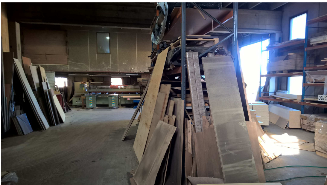
Kuva 8. Palveluvarasto ennen muutosta
