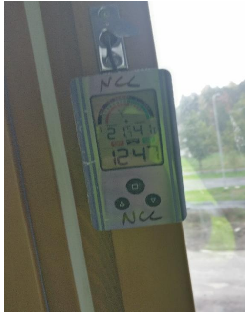
Kuva 5. Sisätiloissa sijaitseva digitaalinen kosteus- ja lämpötilaseurannan mittari.
