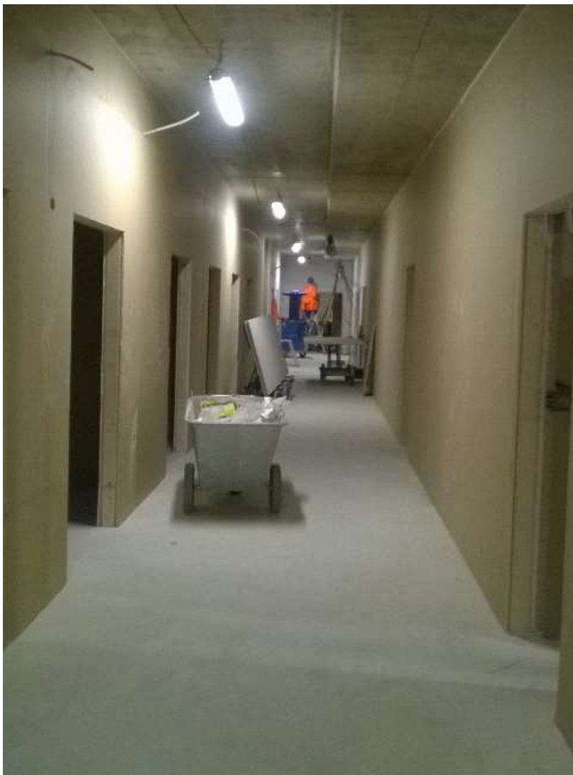
Kuva 3. H-rakennuksen sisärakentamisvaihe. (Joel Kause)
