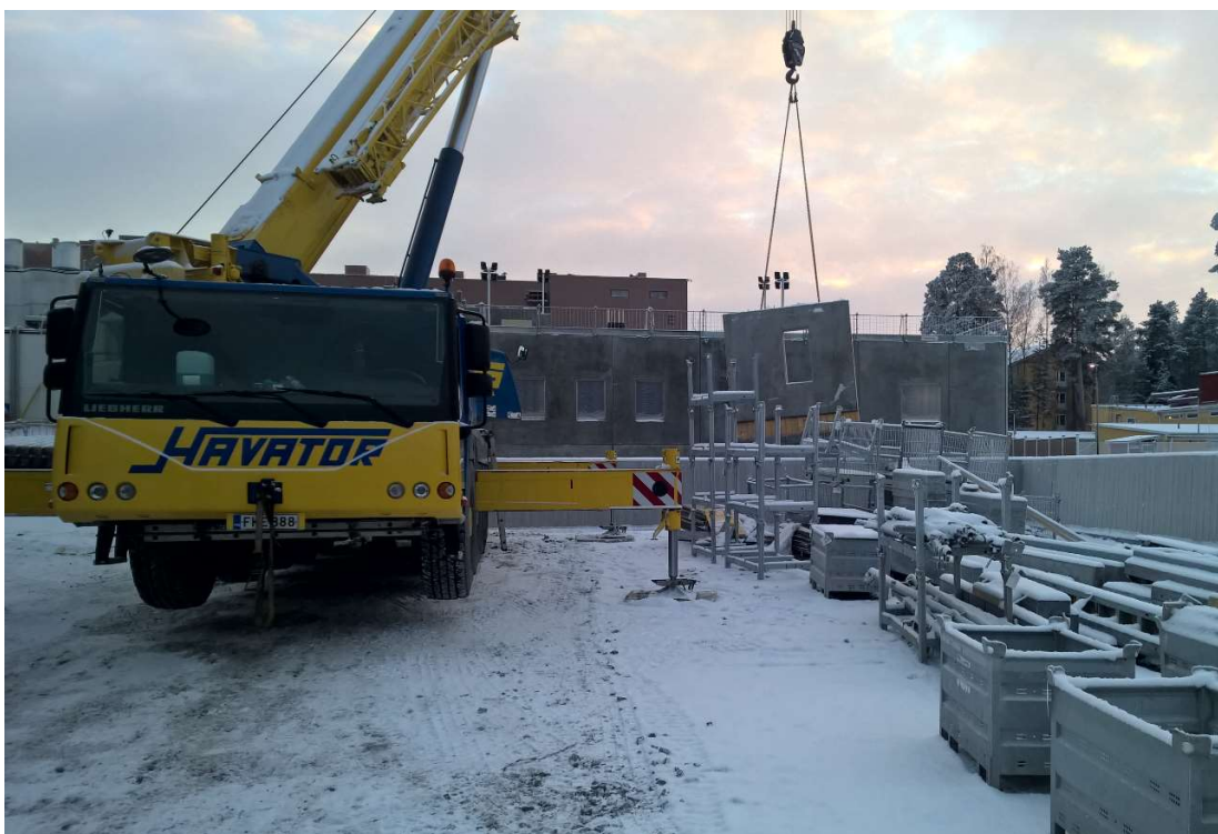
Kuva 2. H-rakennuksen runkovaihe. (Joel Kause)
