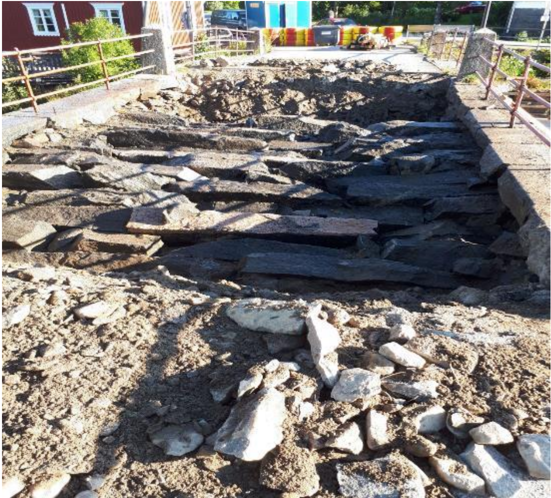
Kuva keskimmäisen kaaren yläpinnasta. Tilanne josta kivien purkaminen aloitettiin.
