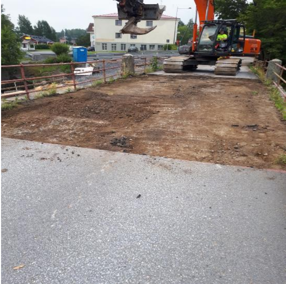
Sillan keskimmäisen kaaren päältä purettiin ensimmäisenä asfalttipinnoite pois.
