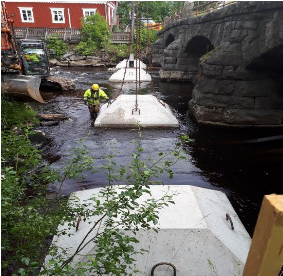
Elementit nostettuina paikoilleen.
