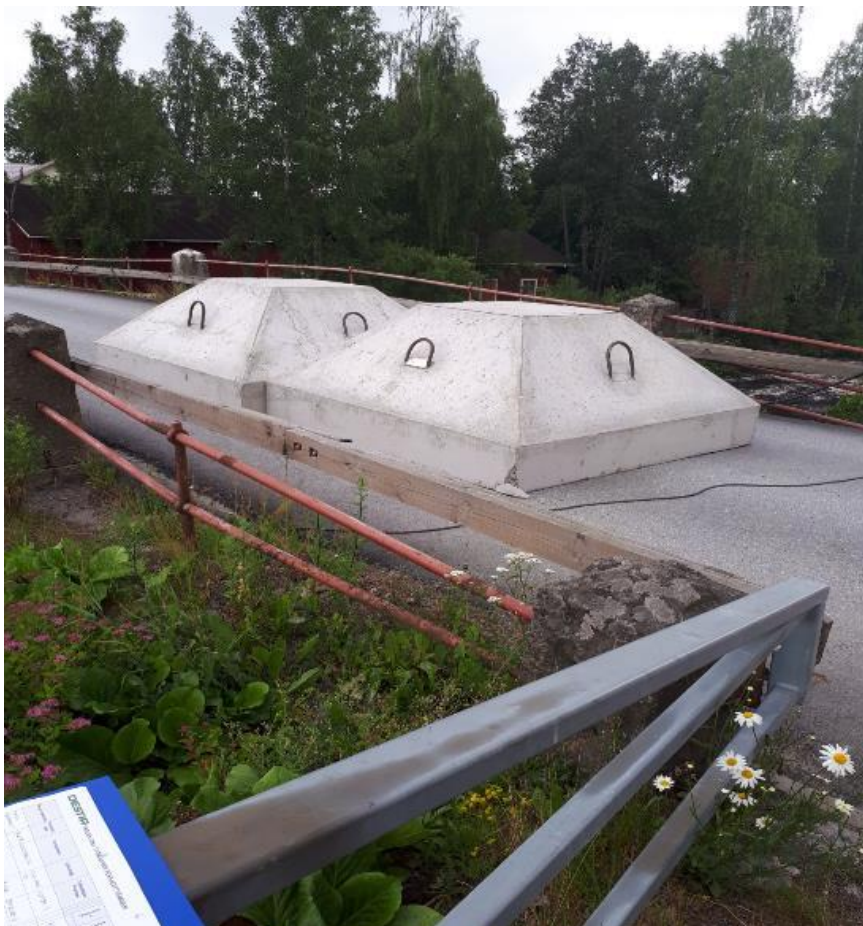
Kivisillan pohjoispuolelle nostetut betonianturaelementit.
