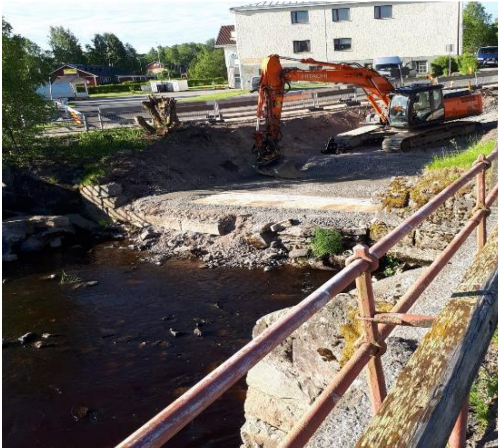
Ajoramppi lähes valmiissa vaiheessa. Rampin alkupäähän upotettiin kaksi pelkkäelementtiä kantamaan ensimmäisten teräspalkkien päihin tulevaa kuormaa.
