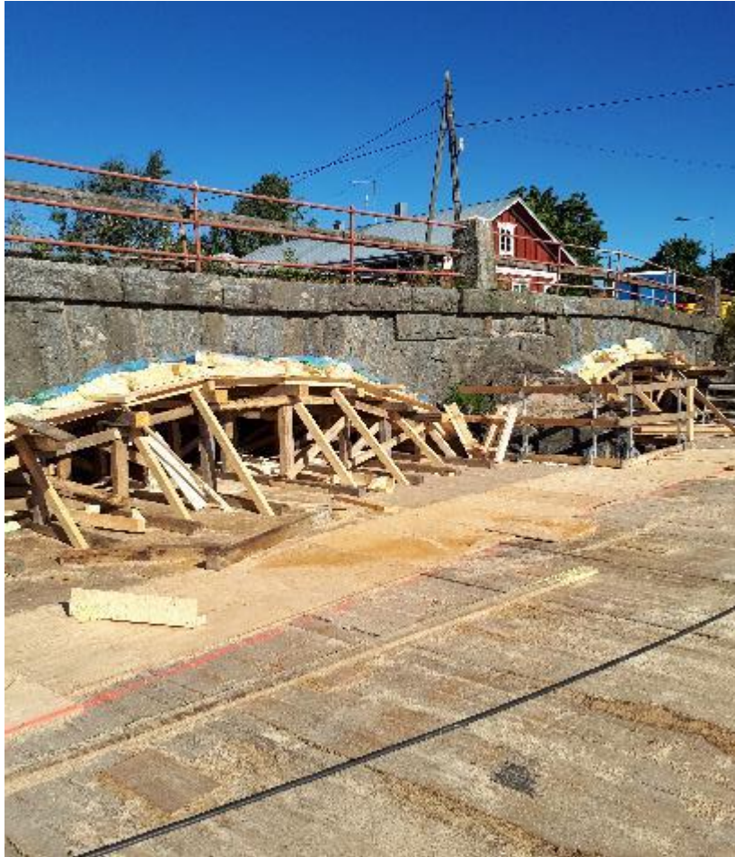
Tilanne polyuretaanitäytön jälkeen. Silta tässä kohtaa siis tuettuna ja valmiina kivien purkamisen aloittamiseen.
