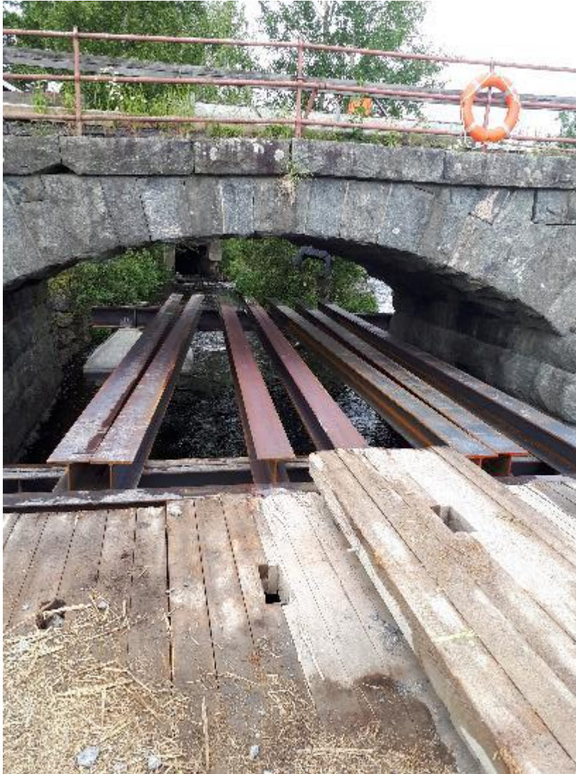
Purkusillan rakenne pääpiirteittäin. Etualalla työsilta.
