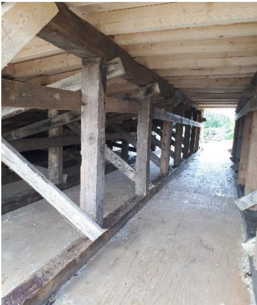
Tukikehikko sisältäpäin. Yläosassa näkyvien 50x100 niskojen päällä 12 mm havuvaneri. Vanerin päällä rako, joka täytettiin polyuretaaniseoksella.
