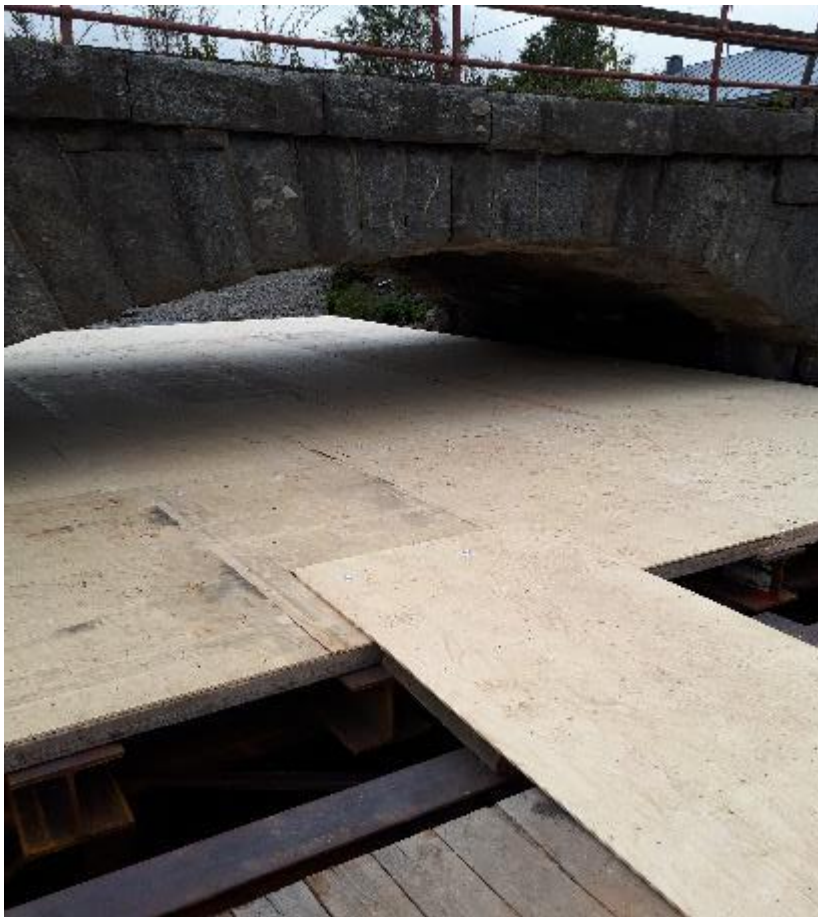
Lähtötilanne tuentarakenteen rakentamisen aloitukseen. Etualalla työsilta.
