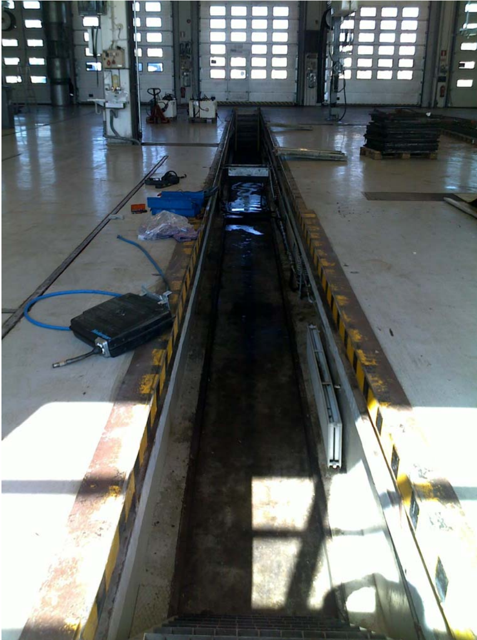
Kuvio 2 : Huoltomonttu, joka täytetään hiekalla ja betonilla
