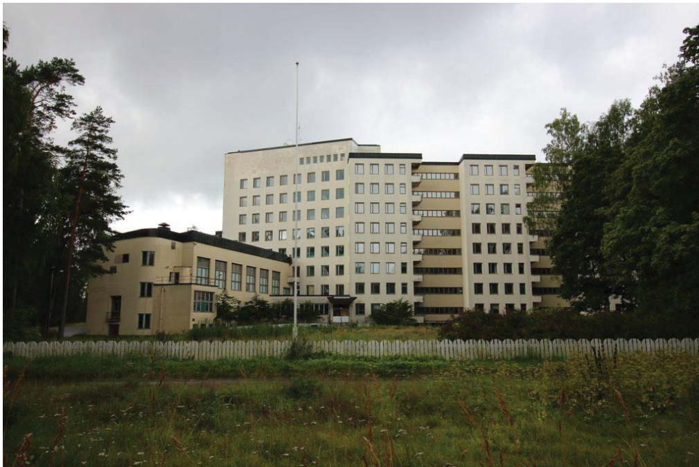
Kuva 6 Pääjulkisivun puolelta Tiurun sairaala on jylhä ja arkkitehtonisesti massiivinen (Pinola, 2015)
