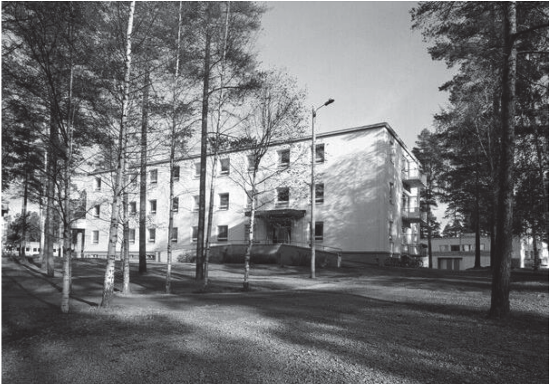
Kuva 19 Vanha tehtaan sairaala nykyasussaan ennen rakennus C:n laajennusta vuosina 1988-90. (Jänis)
