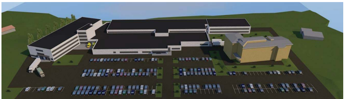
Kuva 30 Ote massoittelumallista. Vanha tehtaan sairaala on kuvan oikeassa reunassa oleva kolmikerroksinen rakennus. (Insinööritoimisto Savolainen, 2016, 23).
