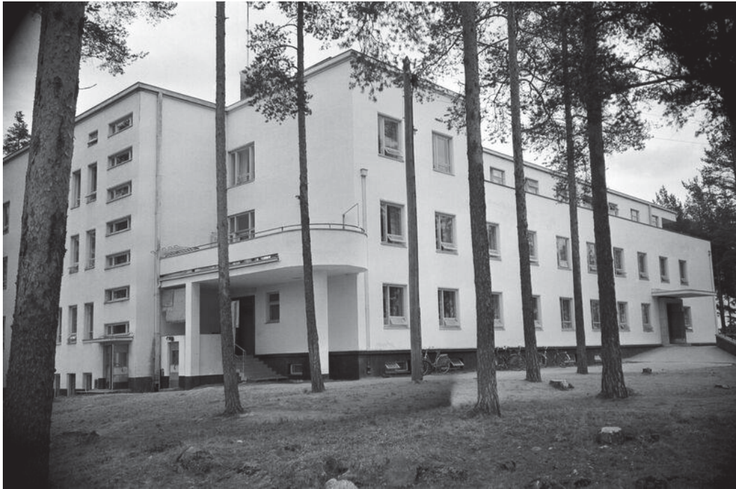
Kuva 17 Vanha tehtaan sairaala, jossa 3. kerroksen länsipäättyyn on tehty laajennus eli rakennettu huonetiloja entisen avoparvekkeen paikalle. (Jänis)
