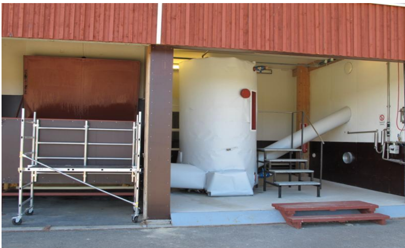
Figur 2. 4m 3 reaktor för tillverkning av biogas i torr mesofil process (Virkkunen Elina, email konversation med Elina Virkkunen 13.3.2018).
