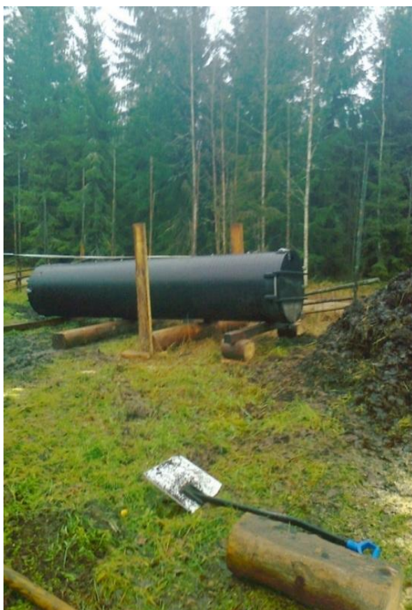
Figur 8. Stödet byggdes under och runt röret.
