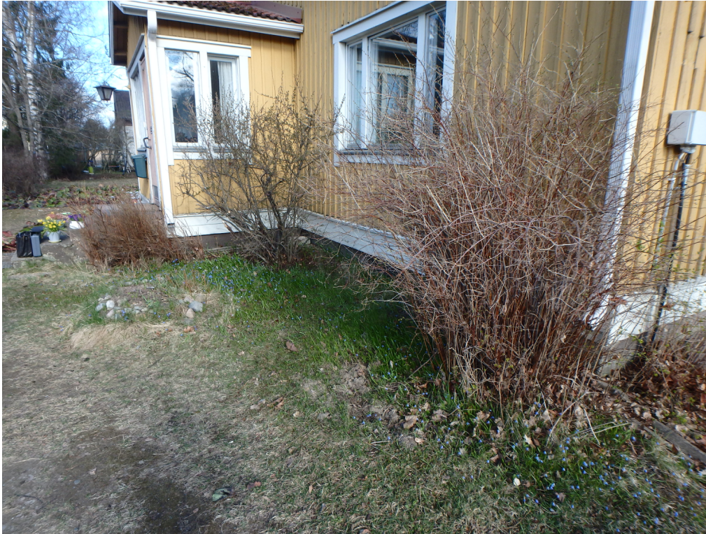
KUVA 13. Kasvillisuutta rakennuksen seinustalla
