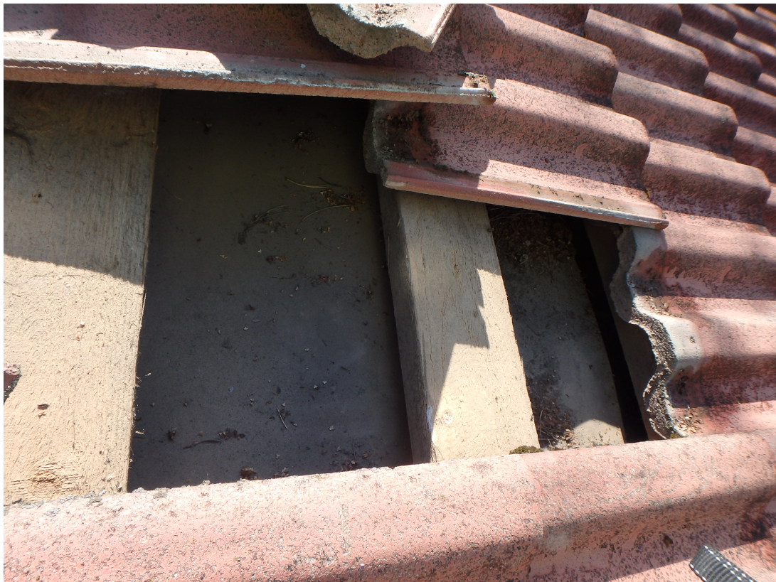
KUVA 9. Katon rakenne tiilen alta katsottuna
