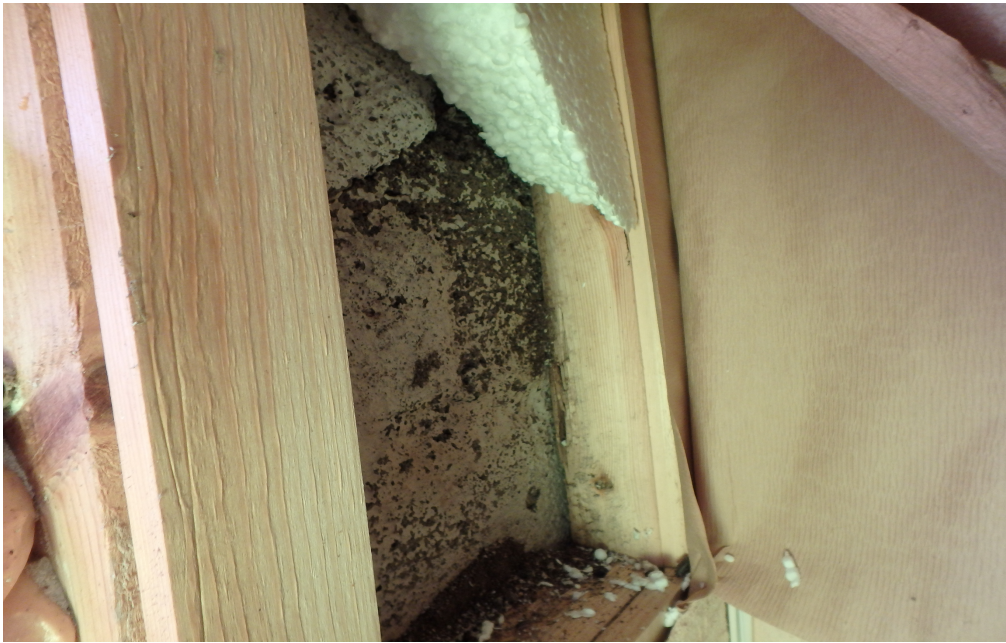
KUVA 17. Avattu rakenne. Puukoolaus kellarin seinää vasten
