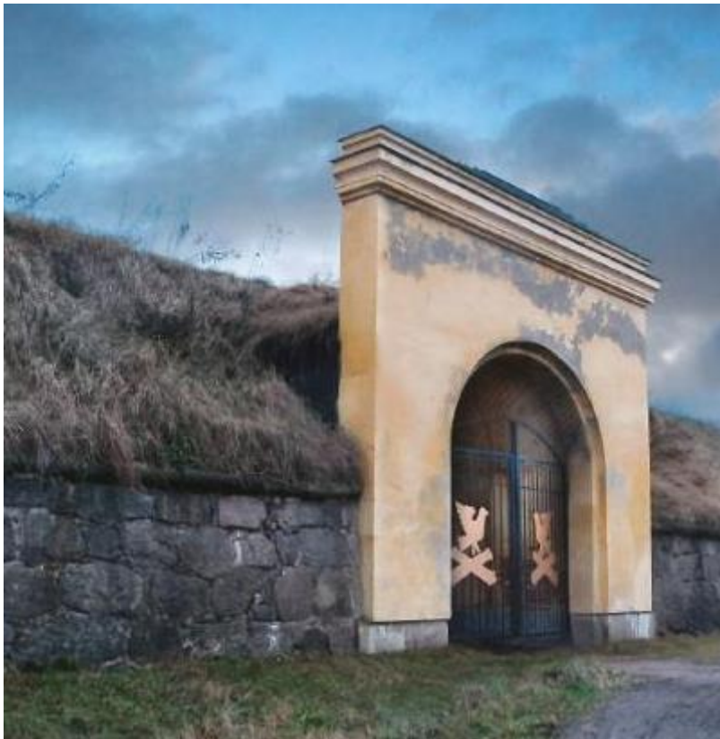
Kuva 34. Kyminlinnan pääportti linnoituksen koillisosassa (Taskinen 2016)
