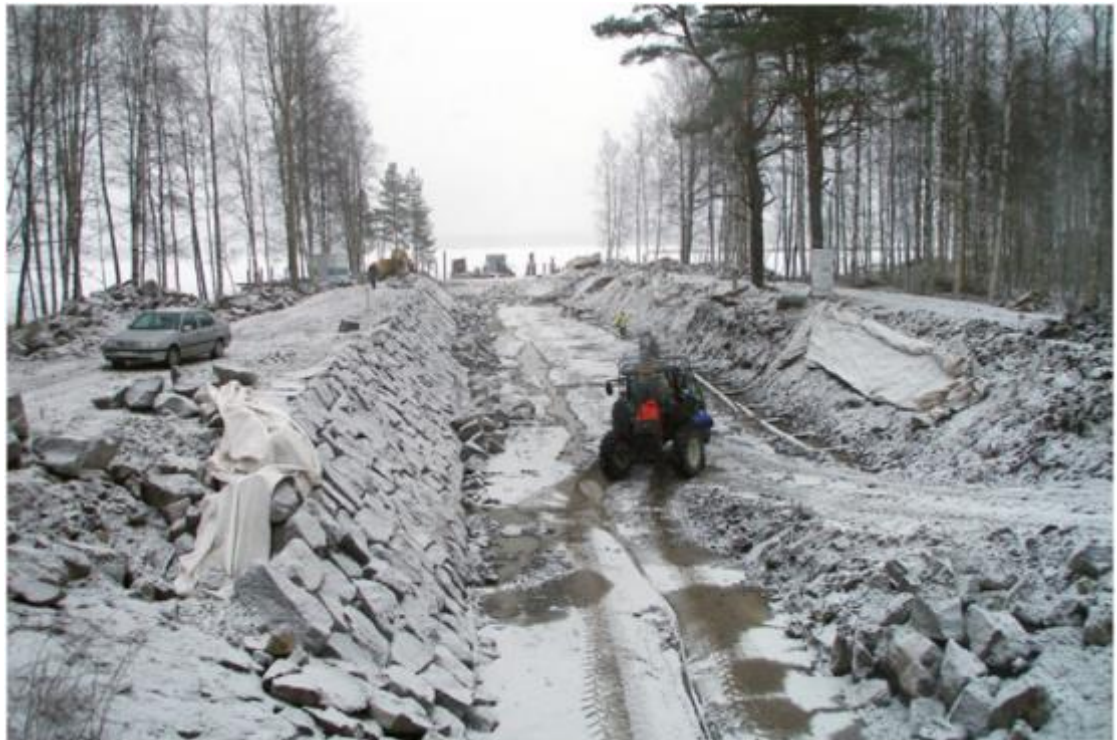
Kuva 59. Telataipaleen kanavan restaurointityö 2006 (Hakala 2005)
