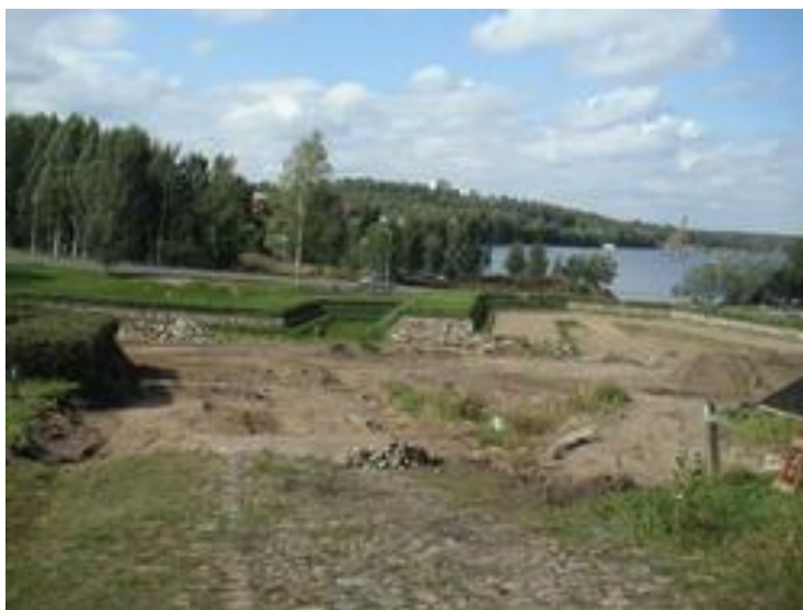
Kuva 18. Näkymä länsivallien työmaalle (Gröndahl s.a.)
