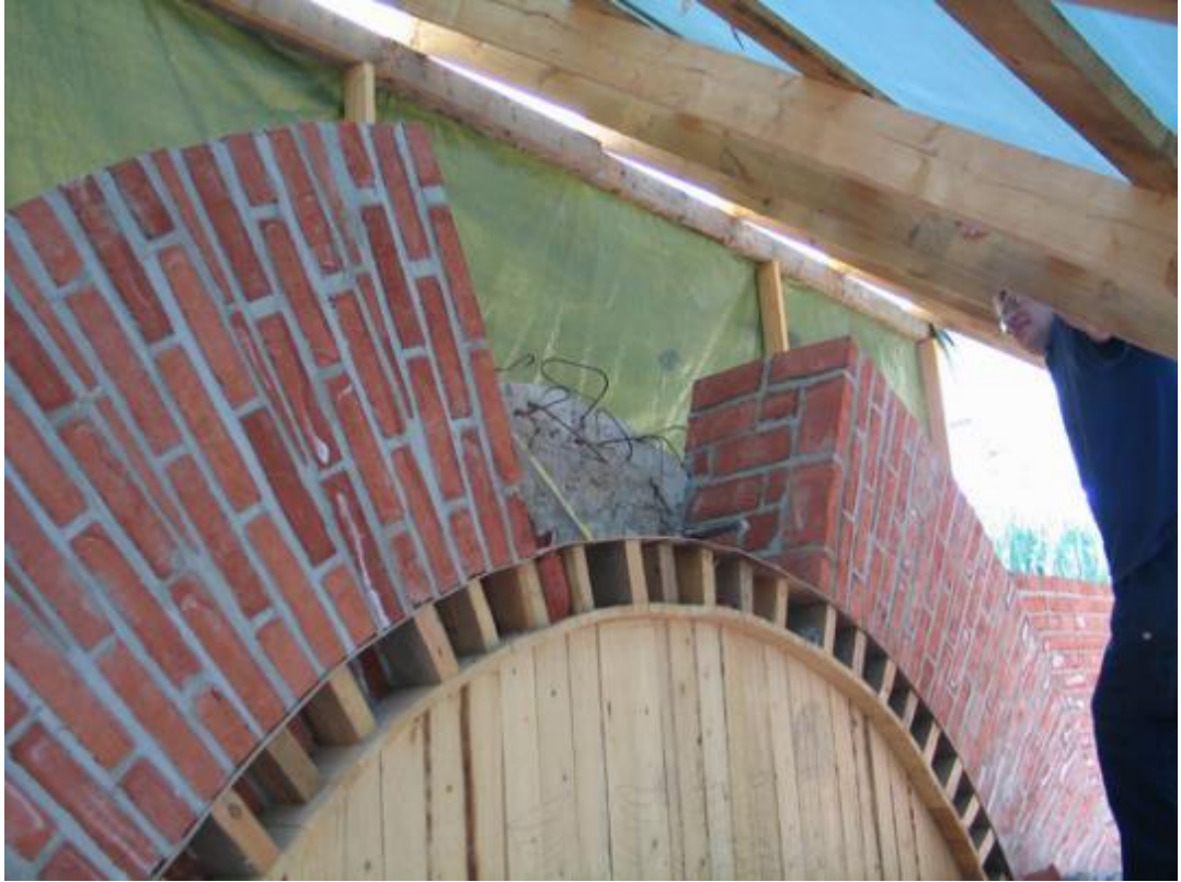
Kuva 33. Koillisportin suuaukon muuraus (Museovirasto s.a.)
