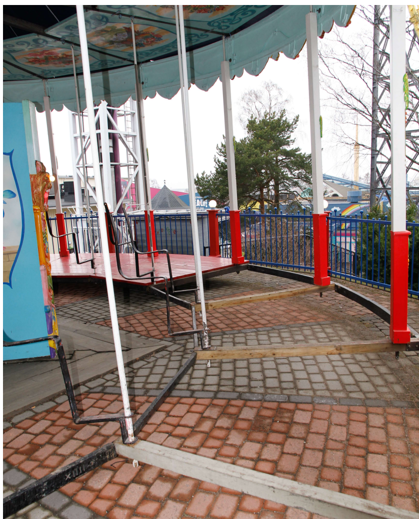
Kuvio 16. Lattiatason rakenneosia ja sisäkehälle muodostuvan penkkirivin tukirunkorautoja.
