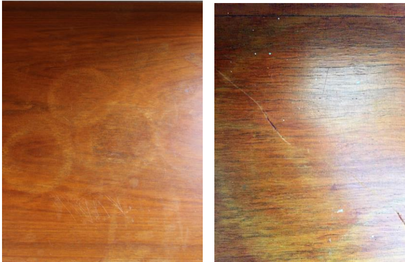
Kuva 13. Kellastuneen ja krakeloituneen lakkapinnan vaurioita: vesivaurioita, naarmuja ja maaliroiskeita.
