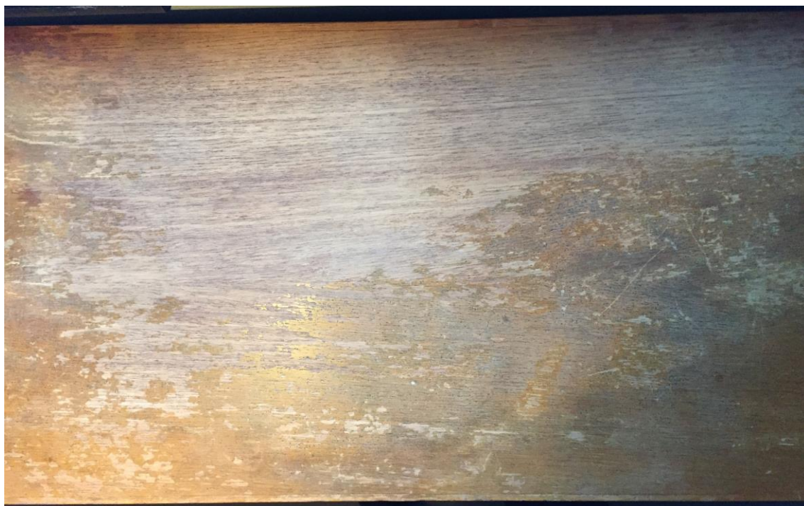
Kuva 18. Lakkapinnan suuri vaurioalue puhdistuksen jälkeen.
