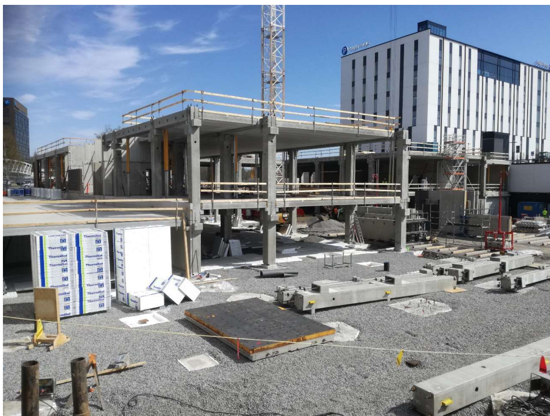
Kuva 5. Ensimmäisen kerroksen lattian ontelolaatat asennettu lohkossa 1.
