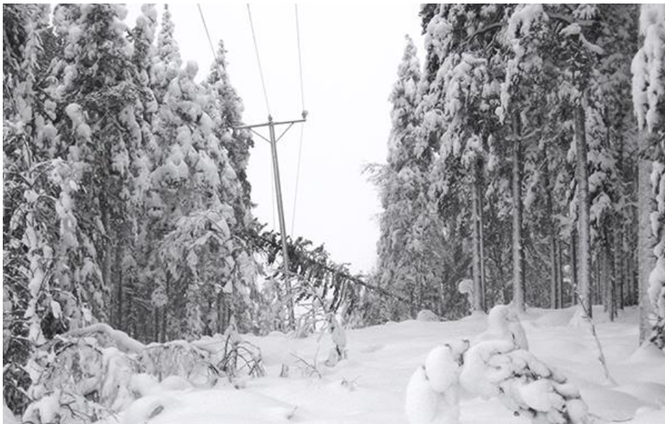
Kuva 3. Ilmakaapelin päälle kaatunut puu tykkylumimetsässä (4).
