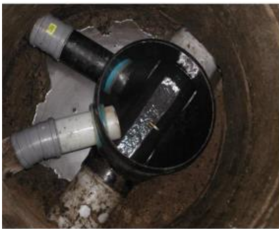
Kuva 31. Asennettu korjauskaivo ja havainnekuva kaivosta [6]
