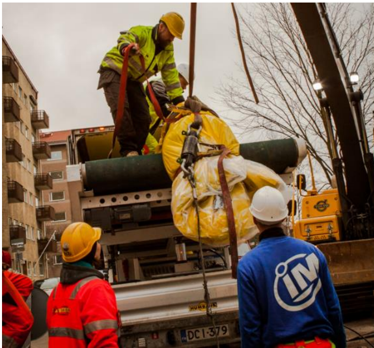
Kuva 17. Vetovaijeri kiinnitettyä sukan päähän valmiina vedettäväksi linjaan [29]
