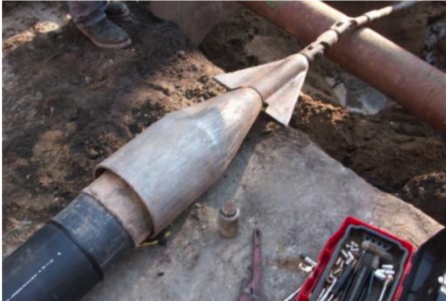
Kuva 7. Leikkuuterä ja avennin [17]
