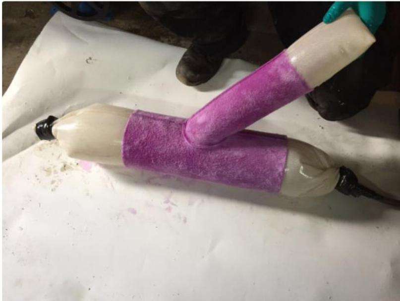
Kuva 22. Haarayhde asennettuna pakkaajan päälle [19]
