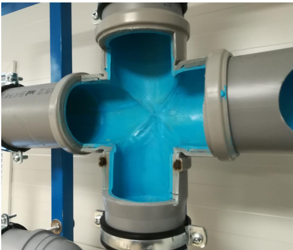
Kuva 23. Tuplahaarayhde asennettuna malliputkistoon [27]
