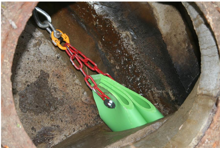
Kuva 11. Vetovaijeri kiinnitettynä muotoputkeen [29]
