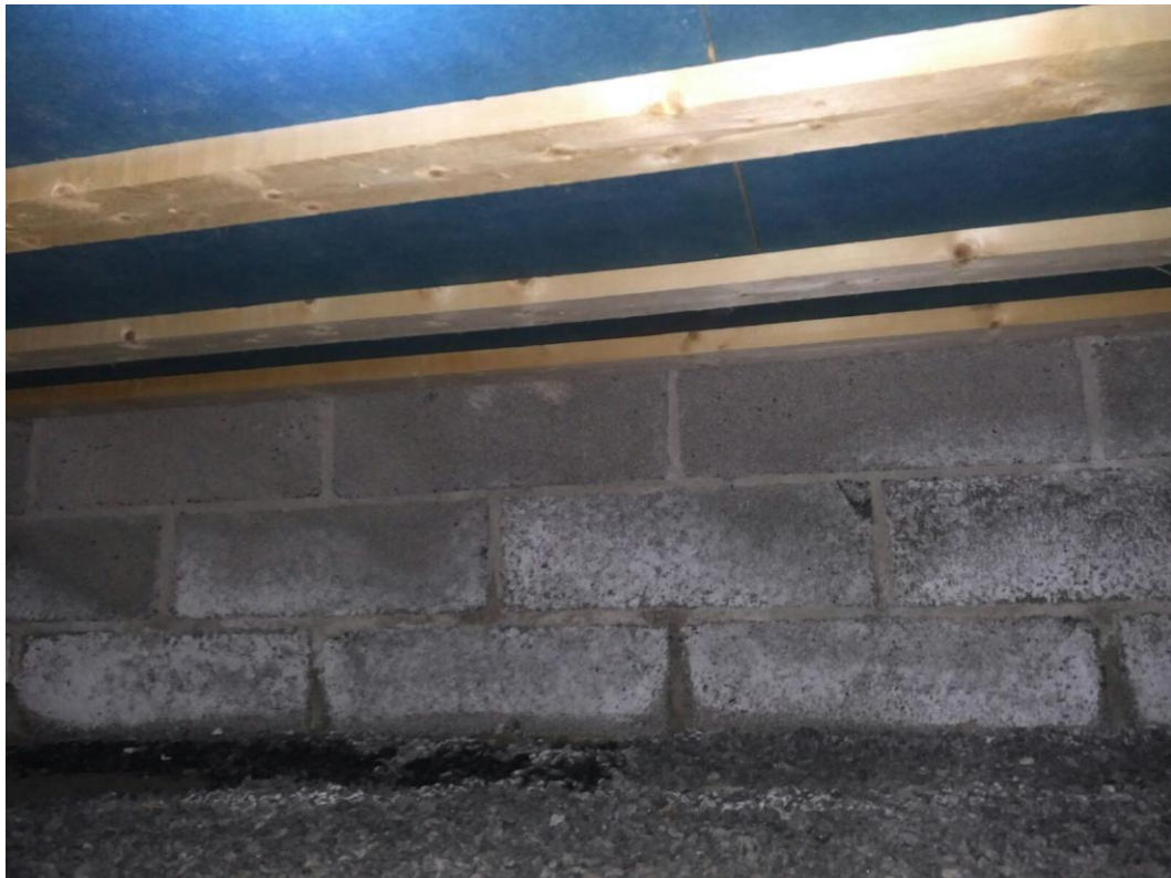
Kuva 4. Sokkelissa olevaa kalkkihärmää.
