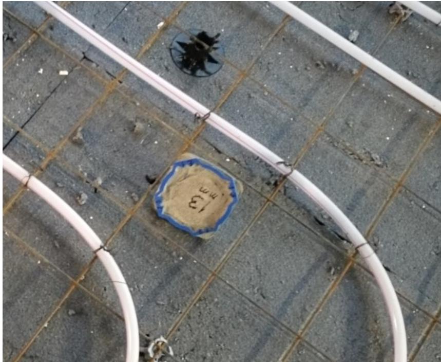
Kuva 15. Kelluva Humi 2 -anturi
