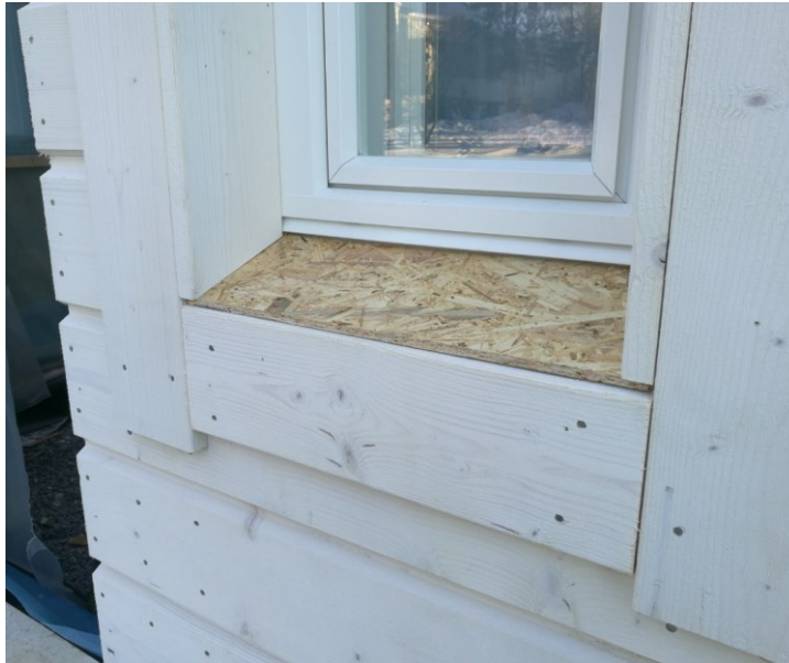
Kuva 5. Ikkunaliittymän väliaikainen suoja
