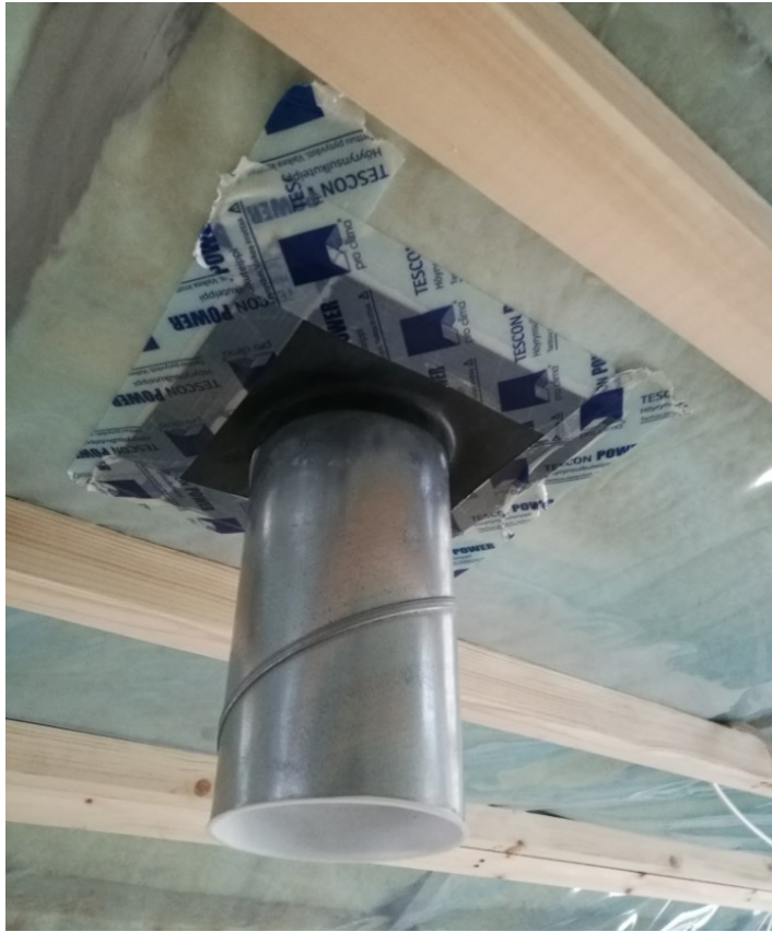
Kuva 8. IV-kanavan läpivientikaulus
