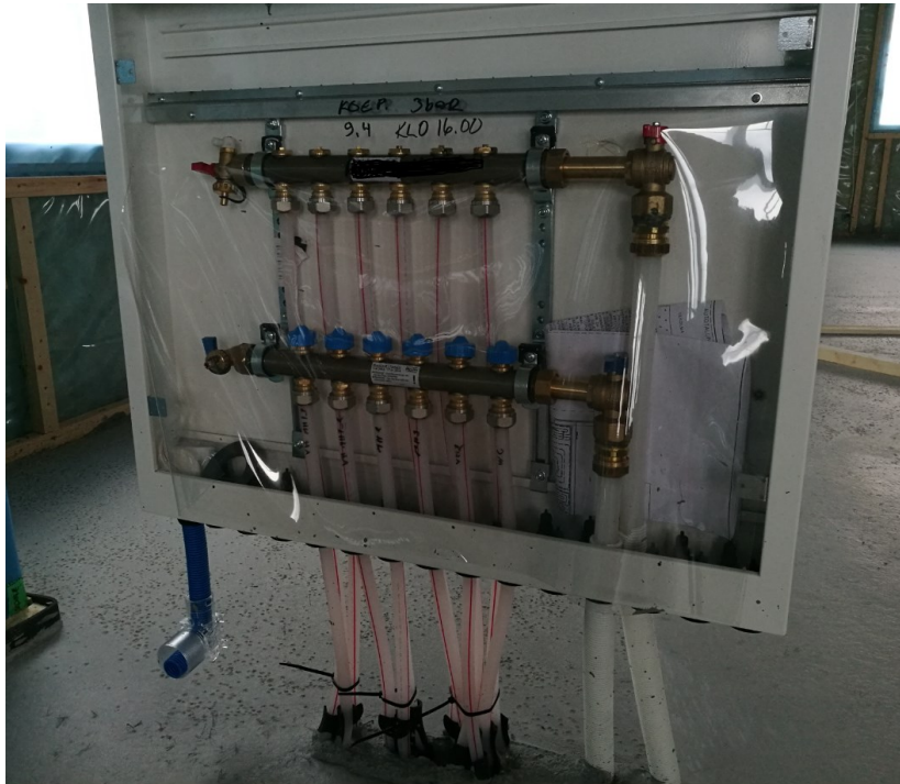
Kuva 11. Seinän sisään asennettava Roth jakotukkikaappi
