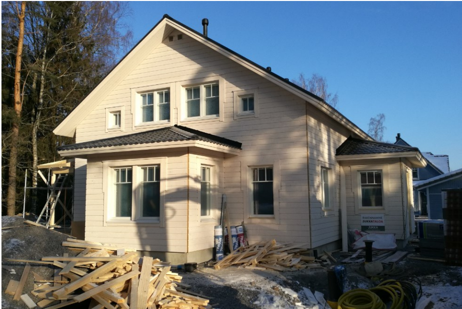
Kuva 20. Vesikatto ja julkisivupanelointi valmiina, 1.3.2018
