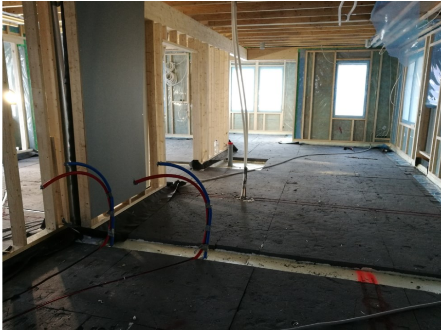
Kuva 22. Alapohjan eristys valmiina, 4.4.2018
