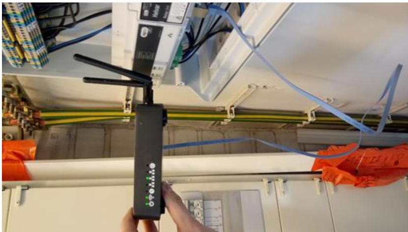
Kuva 33. TOSIBOX-laitteen kytkeminen reitittämiin.
