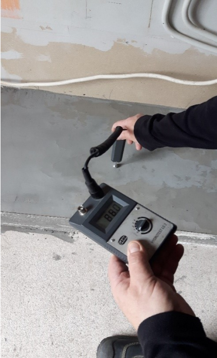
Kuva 2. Pintakosteusmittaus (vahinkokokohde Nummela).
