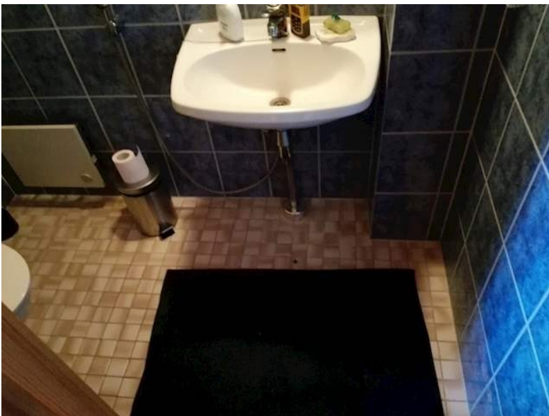
kuva yläkerran wc:stä
