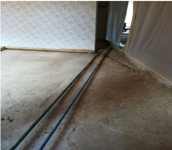
Kuva 4. Lattian purku (työmaa Sammatti).
