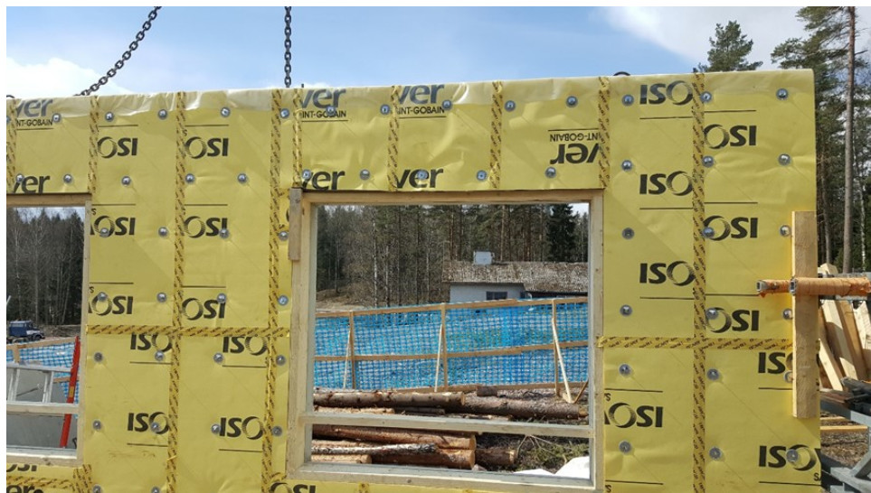
Kuva 5. SK-elementti kuormasta purettuna (Laitinen 2017).
