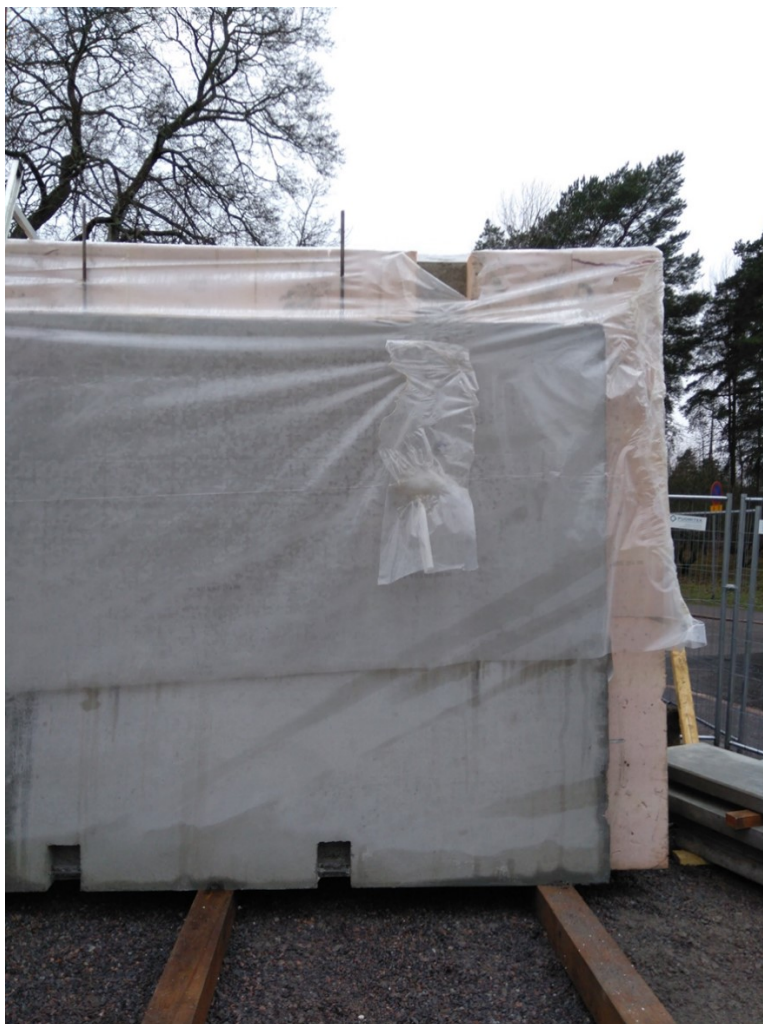
Kuva 7. Betonielementin suojaus (Laitinen 2017).
