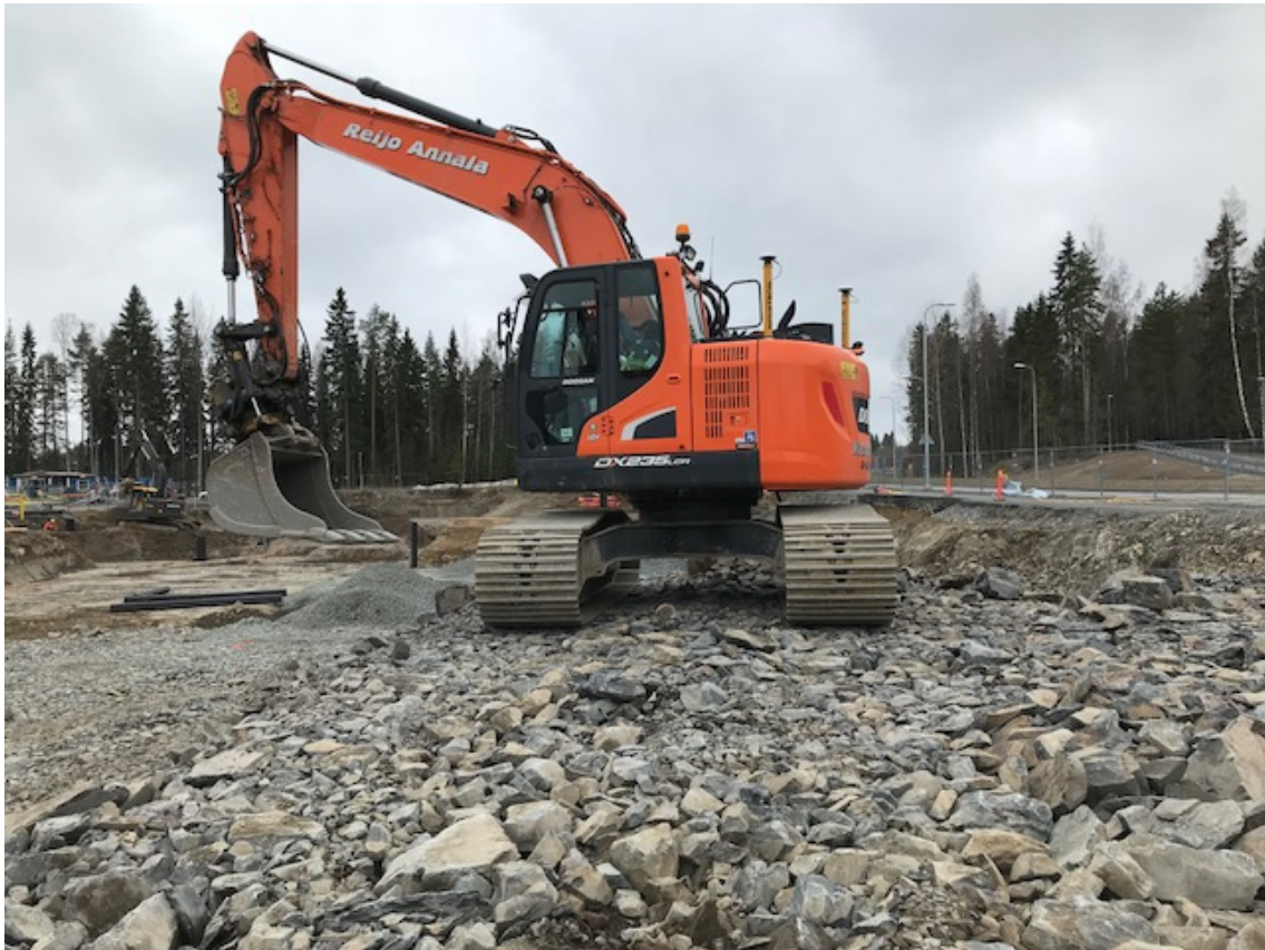
KUVA 8. Työssä käytetty Doosan Dx235 kaivinkone, johon asennettu Novatronin koneohjaus
